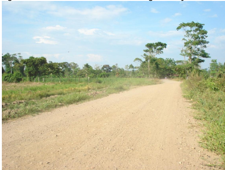
Figura 3.3. Corredor vial existente entre Aguaclara y Guarumito.
