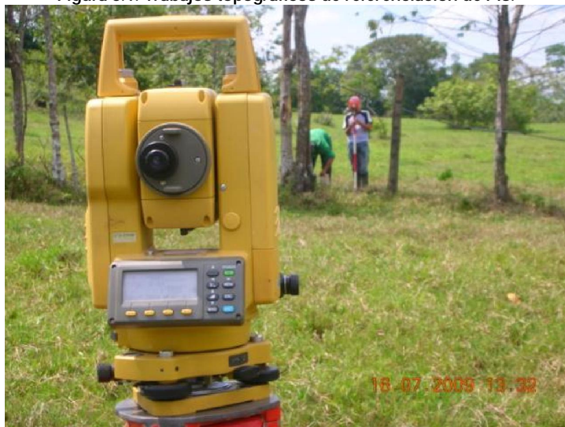
Figura 3.1. Trabajos topográficos de referenciación de Pls.
