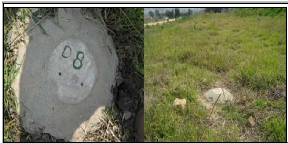
Fotografía 23. Detalle de los mojones y la referencia tomada para el control de asentamientos y movimientos horizontales.
