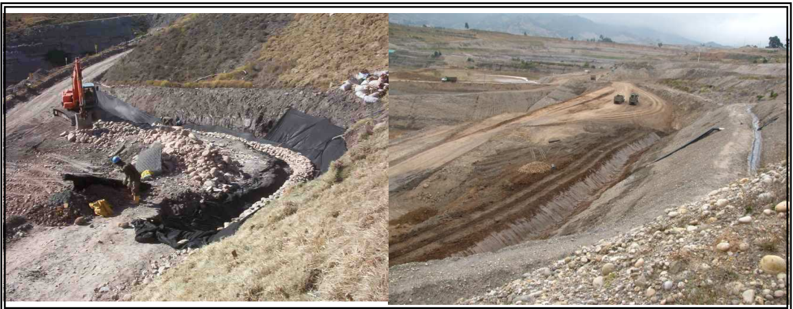
Fotografía 13. Construcción Filtro Volumétrico. Excavación, tallado, extendido geotextil y disposición de piedra para filtro.
