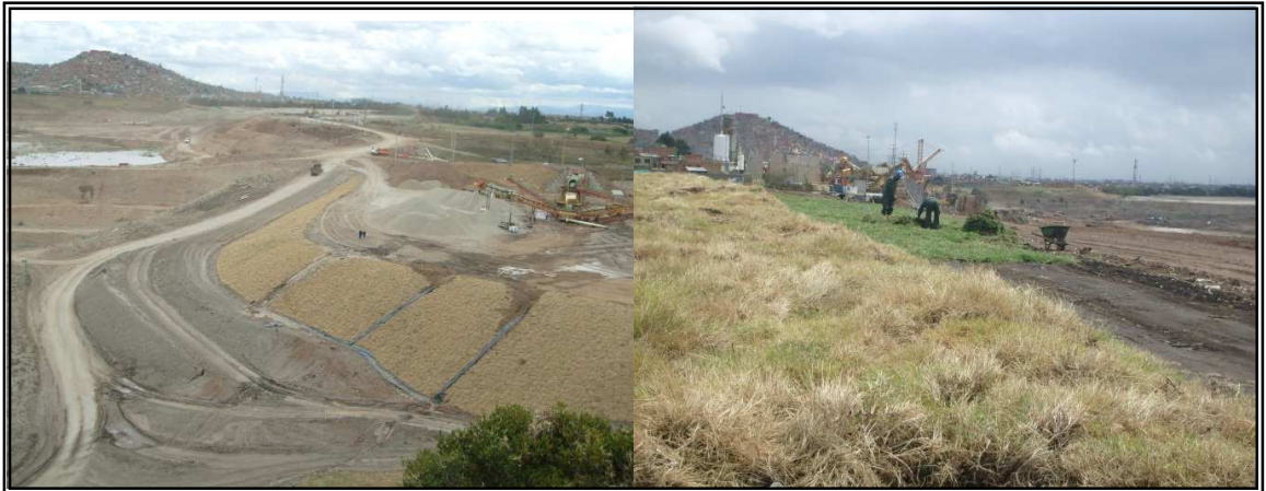
Fotografía 20. Labores de extendido de cespiones de pasto kikuyo sobre tierra negra ( Pennisetum clandestinum H.).
