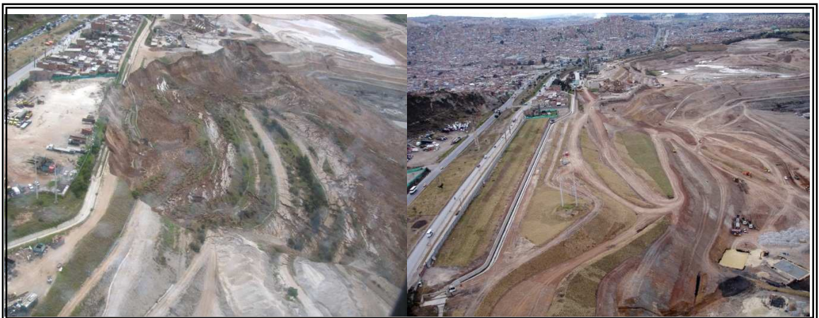
Fotografía 21. Cambios morfológicos y paisajísticos en el área del deslizamiento.
