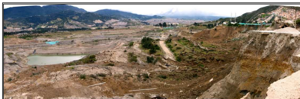
Fotografía 5. Vista lateral de la masa deslizada y su fragmentación en bloques.
