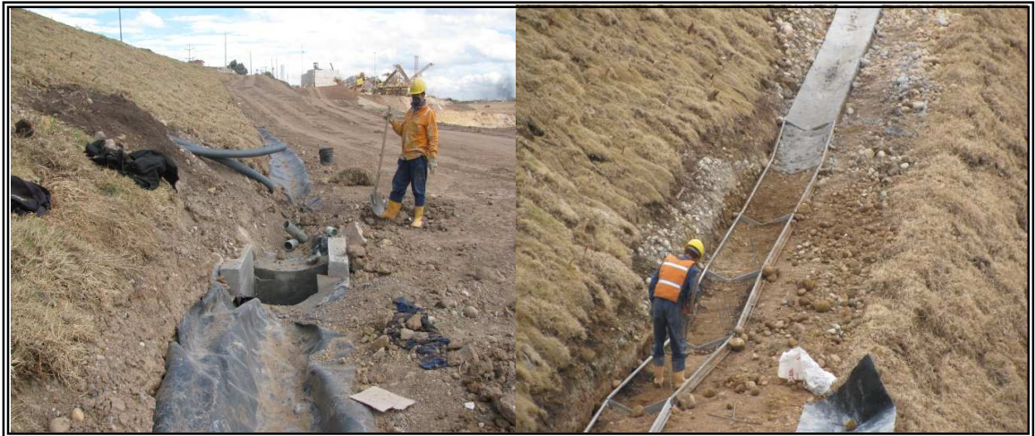
Fotografía 17. Cunetas recubiertas con geomembrana, caja colectora y distribuidora de agua
