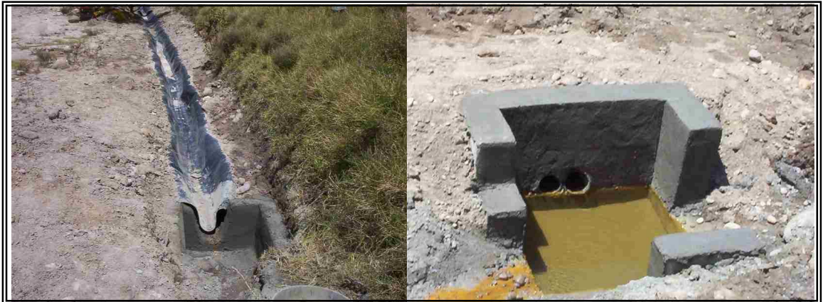
Fotografía 15. Construcción cunetas revestidas en geomembrana y cajas para distribución del agua a una terraza inferior a través de la mangueras de 3".
