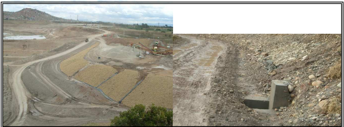
Fotografía 16. Marco izquierdo: Filtros transversales en las caras de los taludes. Marco derecho Caja para captación y distribución del agua a las terrazas inferiores
