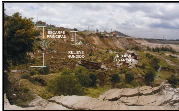
Fotografía 6. Morfología de la parte superior del deslizamiento.
