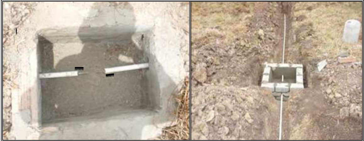
Fotografía 24. Extensómetros instalados sobre material conformado en las terrazas superiores el talud Codeipa. Varillas de ½" en forma de L ancladas sobre el terreno. La deformación horizontal se mide con un calibrador por la el movimiento relativo en los extremos de las varillas.
