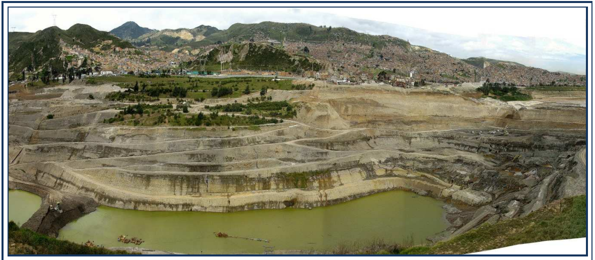
Fotografía 1. Panorámica Antes del Deslizamiento
