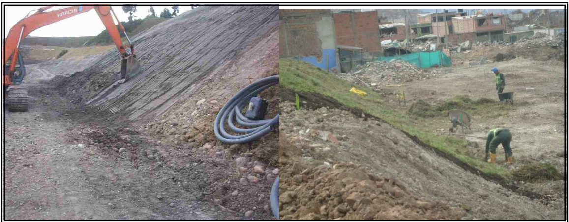
Fotografía 18. A la izquierda compactación, tallado y perfilado de taludes. A la derecha repoblación vegetal de taludes finales (parte alta de talud fallado).
