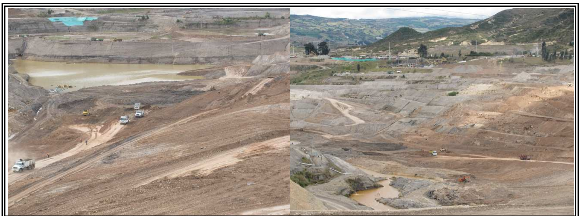
Fotografía 10. Disposición técnica, en la parte baja de la masa deslizada, de escombros como contrapeso de estabilización.
