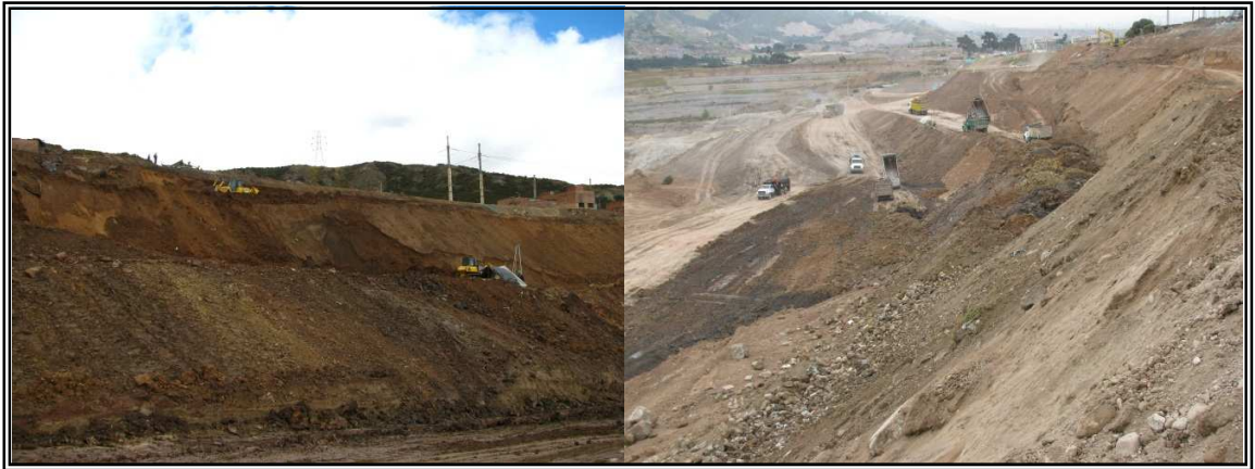
Fotografía 9. Terraceo en el escarpe del talud fallado y construcción de contrapesos en la parte baja y media del talud deslizado.
