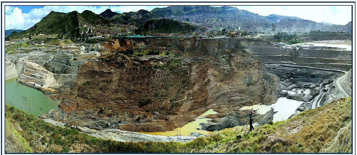
Fotografía 2. Panorámica post – deslizamiento
