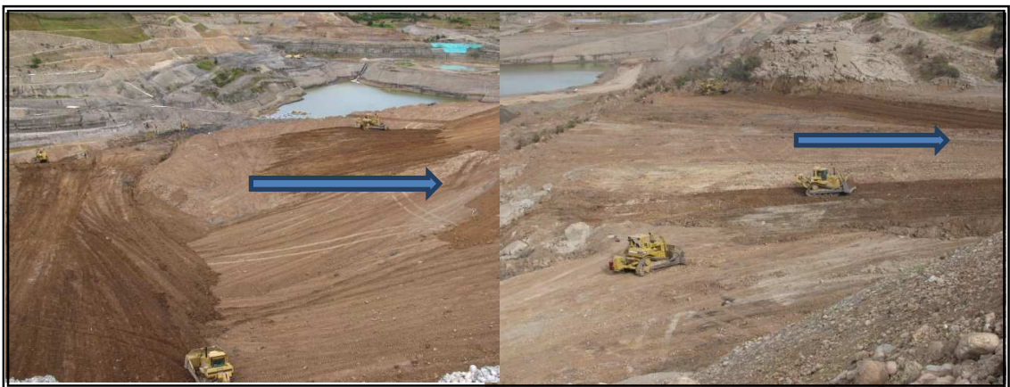
Fotografía 7. Operación de buldózer según indica la flecha: de acuerdo a la topografía de abajo hacia arriba, confinando la parte baja del escarpe de falla.
