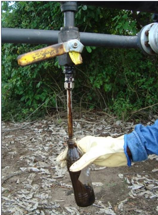
FIGURA . Válvula tomamuestras del manifold del pozo
