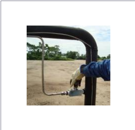
FIGURA . Válvula tomamuestras de cabeza de pozo.
