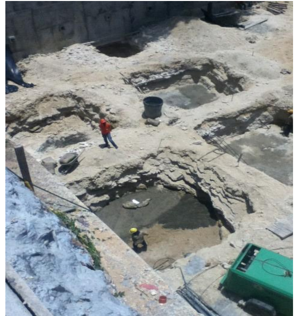
IMAGEN 3. Excavación de zapatas y solado.
