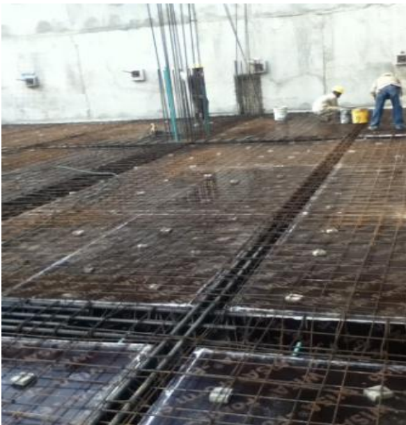
IMAGEN 14. Armado de refuerzo de la losa.
