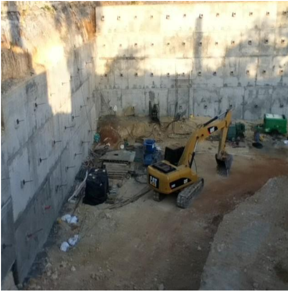
Imagen 1. Muros pantalla
