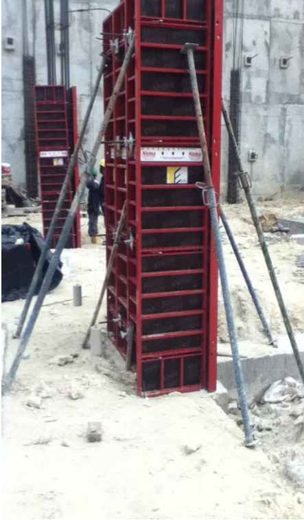
IMAGEN 17. Formaleta metálica en usada en columnas.
