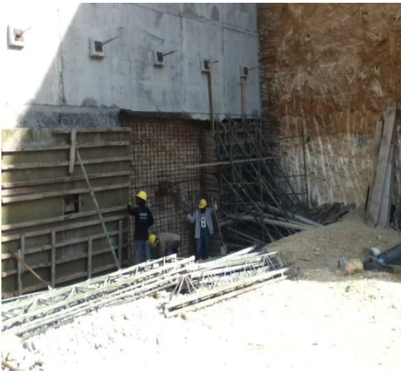
IMAGEN 2. Armado de refuerzo y encofrado de los muros pantalla.
