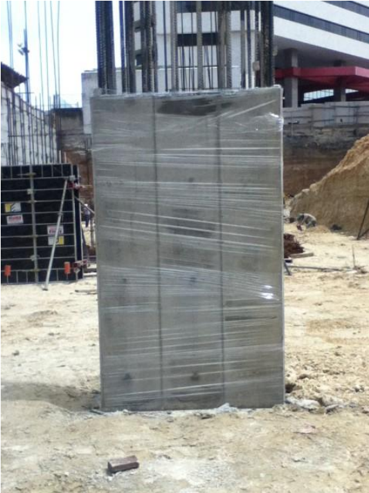
IMAGEN 9. Protección de columna para mantenerla húmeda.
