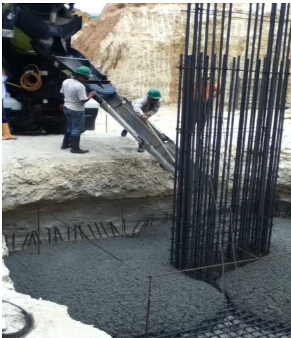
IMAGEN 6. Vaciado de zapatas.
