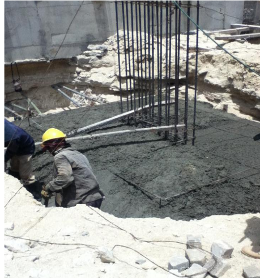
Chequeo en vaciado de zapatas.
