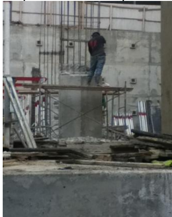
Demolición de columna debido a junta peligrosa.
