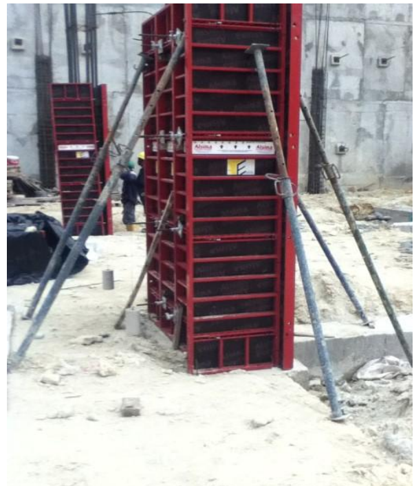
IMAGEN 8. Encofrado de columnas.
