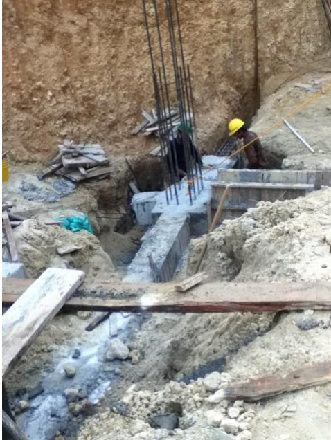
IMAGEN 10. Vigas de amarre
