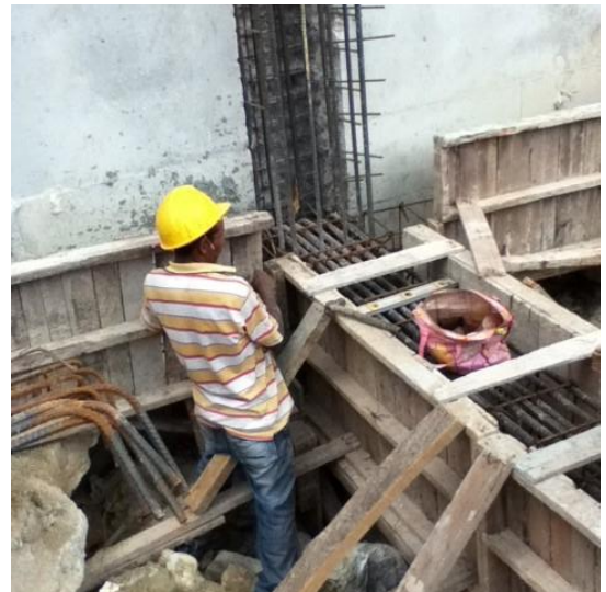
IMAGEN 7. Encofrado de vigas de amarre y perforación de muros pantalla.
