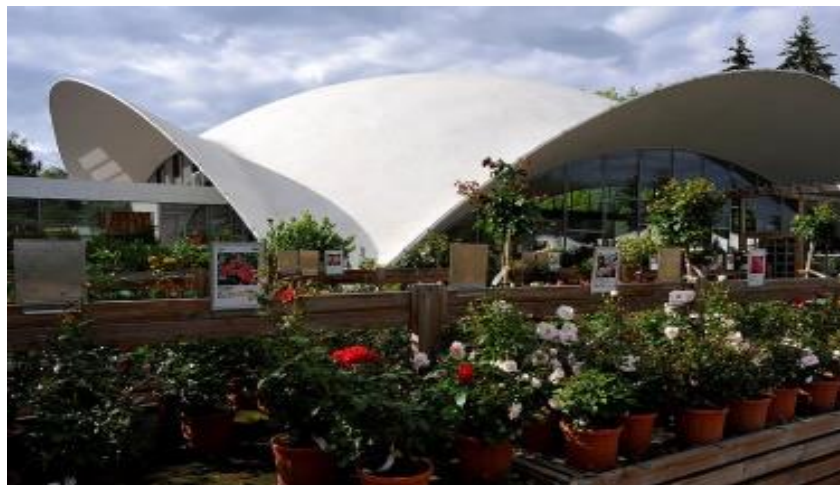
Figura 4. Techo de concreto cáscara del centro de jardinería Wyss en Zuchwil
