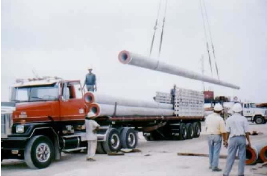
Figura 1.2. Cargue de los postes en el momento de ser transportados
