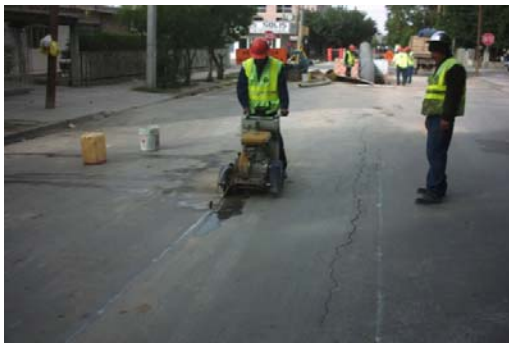
Figura 2-9: Corte del Pavimento (Extracción de Especímenes en Campo)
