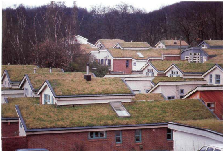
Figura 2. Urbanización de techo verde en Düsseldorf-Unterbach (Alemania).
