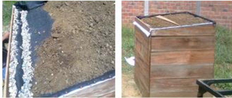
Figura 23. Filtro y sustrato del techo verde.
