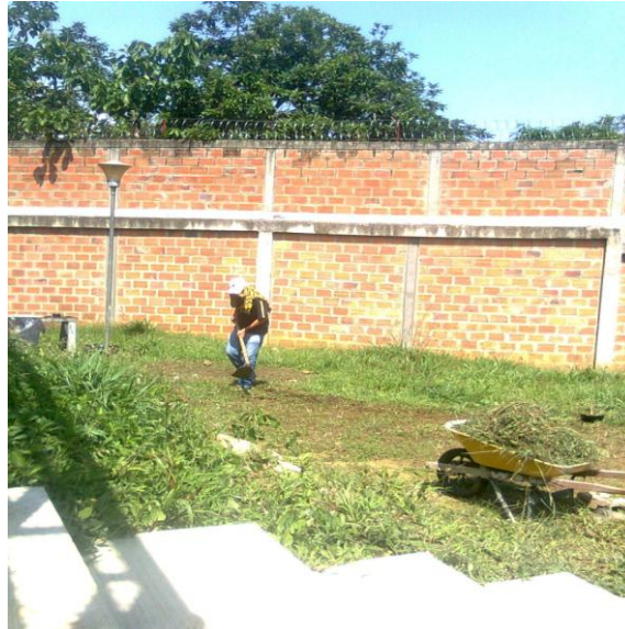
Figura 16. Adecuación del terreno.
