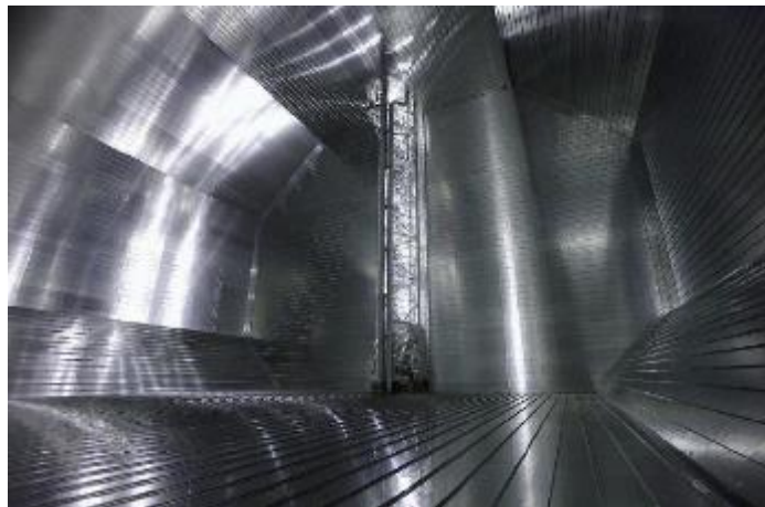
Figura 36. Interno tanque tipo membrana
