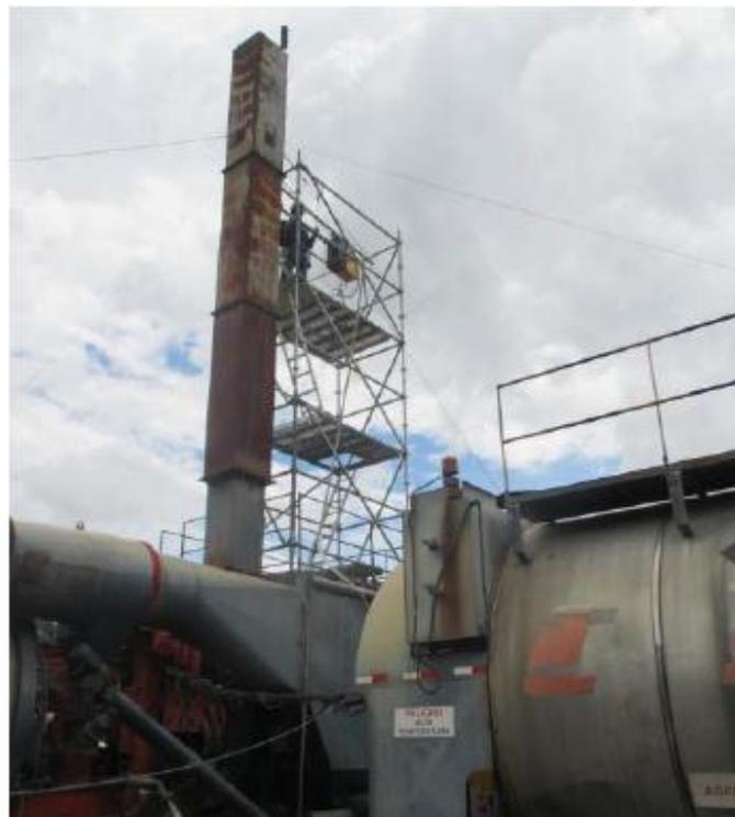
Figura 4. Chimenea y tanques de calentamiento del asfalto
