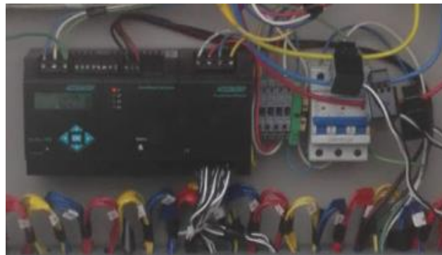
c. AcuRev instalado en la terraza
