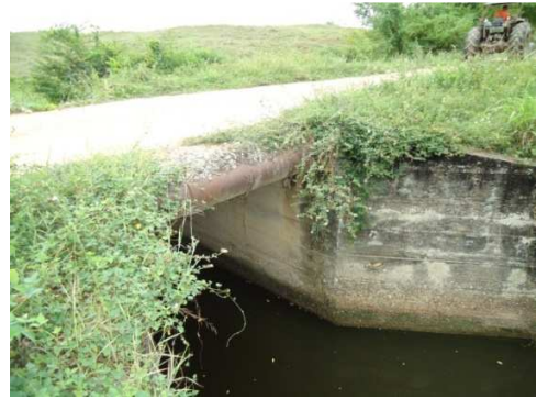
Fotografía 16 Puente combinado; concreto reforzado y tubería metálica. E 1,045,480 N 1,397,174
