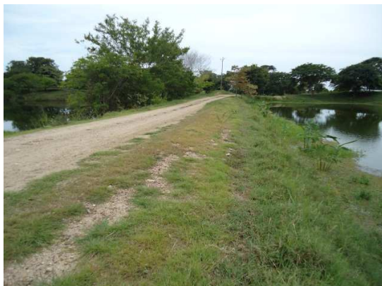
Fotografía 7 Vía de acceso a la Finca El Indio E 1,045,135 N 1,397,310
