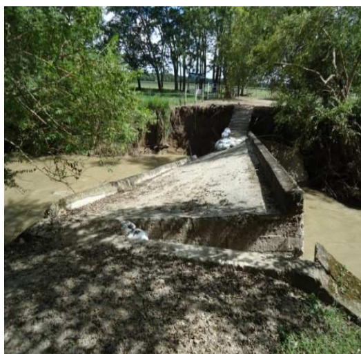
Fotografía 5 Aspecto del puente sobre la Quebrada Peralonso en el K4+350
