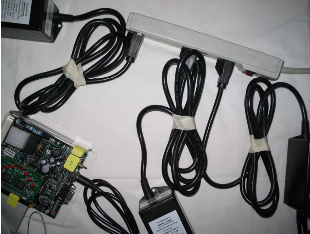
Figura 16 La conexión de los tres nodos a un barraje o multitoma 120 Vac
