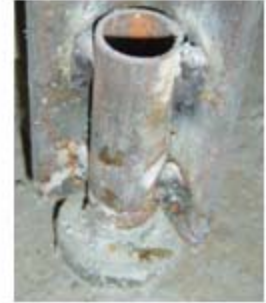
Figura 43. Soporte de la estructura
