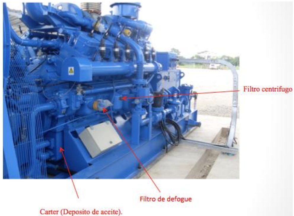
Figura No 16. Subsistema de lubricación
