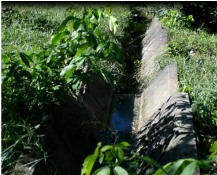
Figura 18. Canal de vertimiento de aguas residuales de la estación de gas de Gibraltar.
