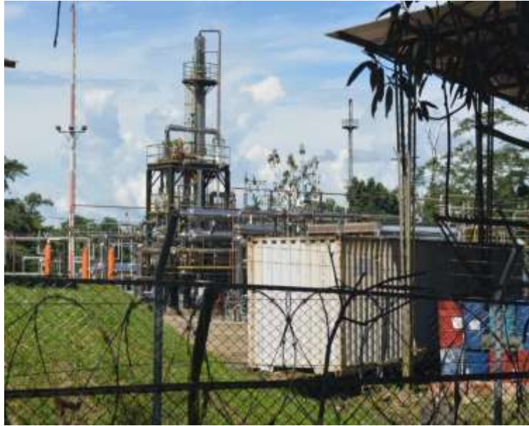
Figura 17. Imágen panorámica de la estación de gas y la Tea de quema.
