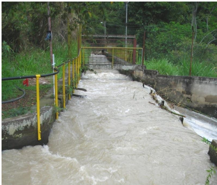
Figura 3. Canal de conducción
