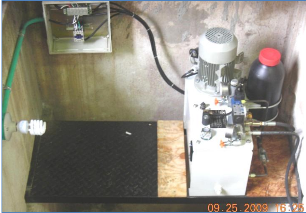
Figura 42. Montaje conjunto hidráulico
