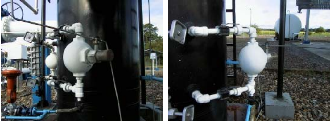
Figura 81. Interruptor Nivel Alto
