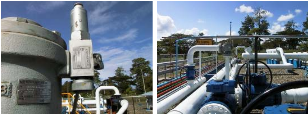
Figura 71. Válvula piloto (Succión)
