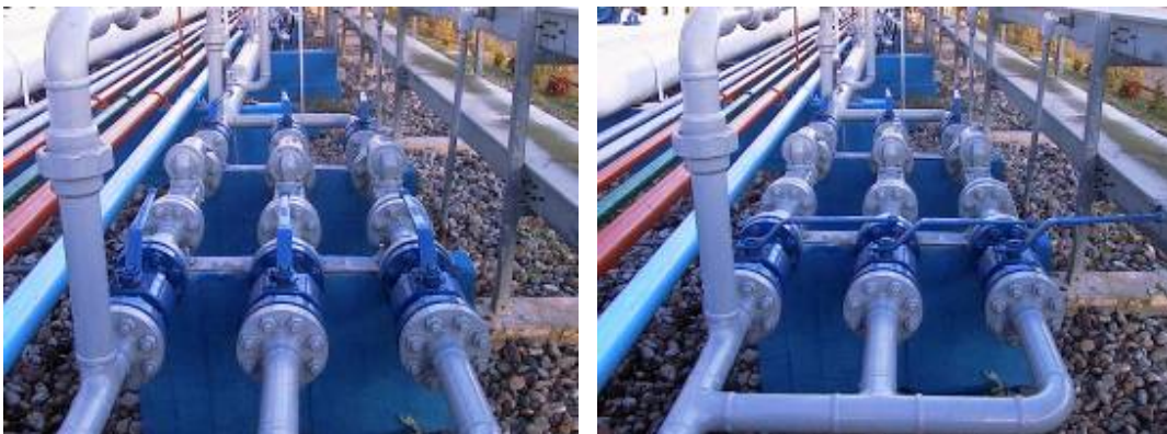
Figura 59. Se cierran Big-joe de combustible
