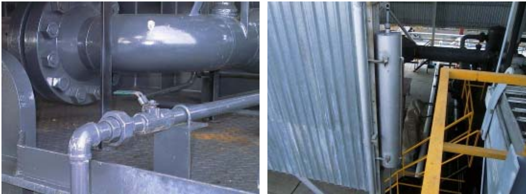
Figura 56. Se cierra válvula de aceite de la unidad
