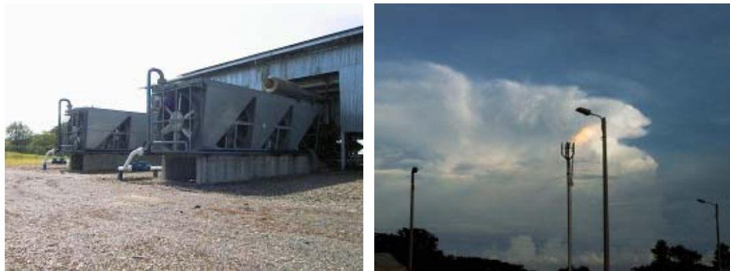
Figura 8. Intercambiadores de calor Coolers y Tea
