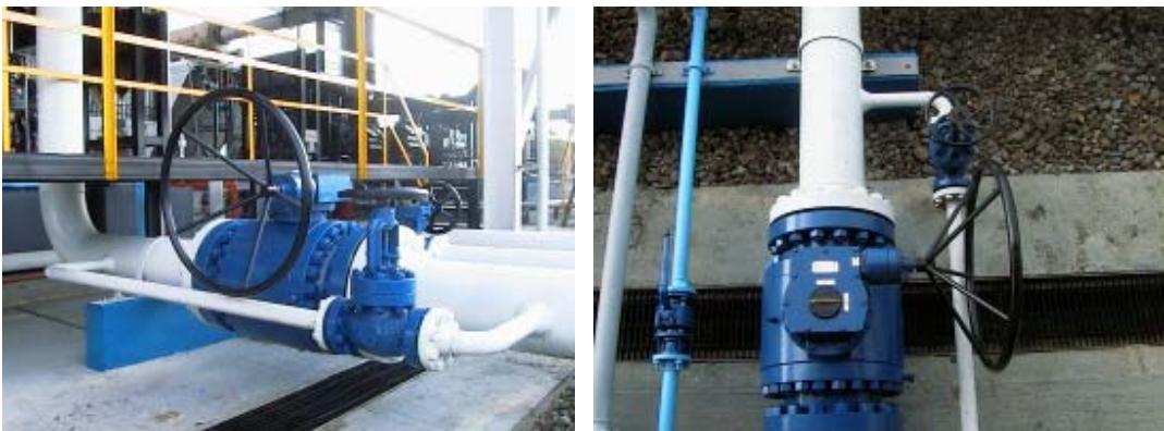
Figura 91. Se cierra válvula de succión de la unidad
