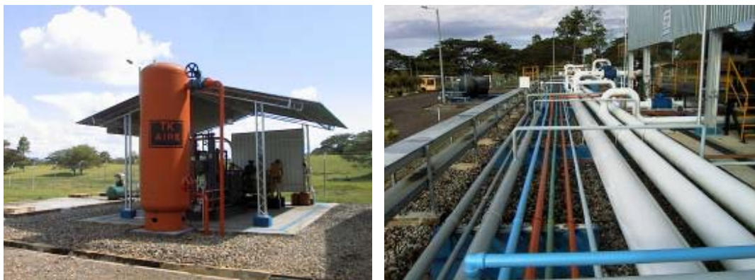
Figura 12. Suministro de aire y sistema de tuberías
