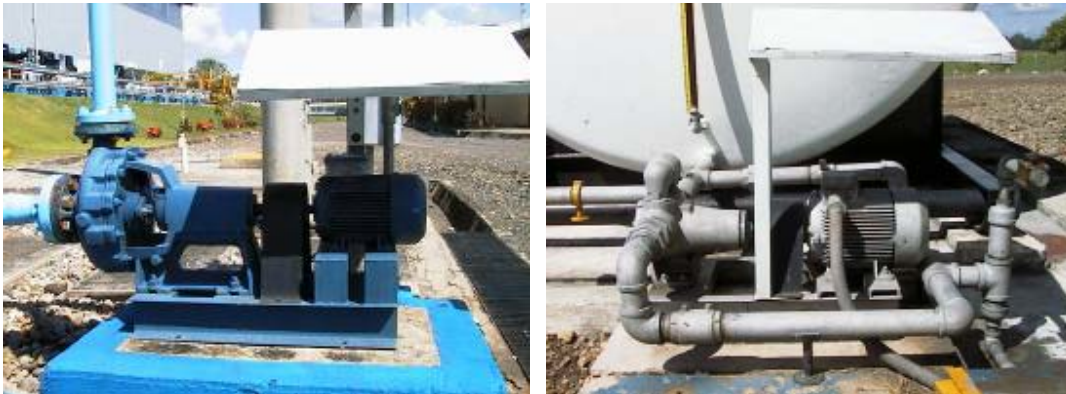
Figura 94. Bombas tanque de condensados y aceite
