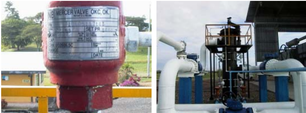
Figura 73. Válvula de seguridad UV (Filtro Coalescente)
