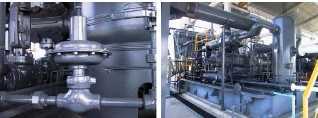
Figura 78. Válvula Neumática de Condensado (Unidad 1)
