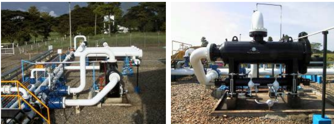
Figura 18. Filtro de succión o Scruber
