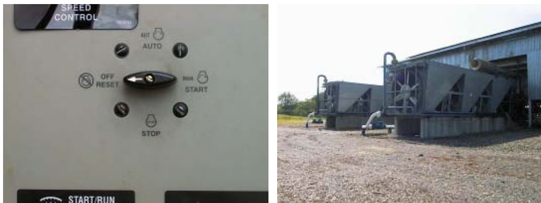
Figura 92. Colocar la unidad en condición de parada
