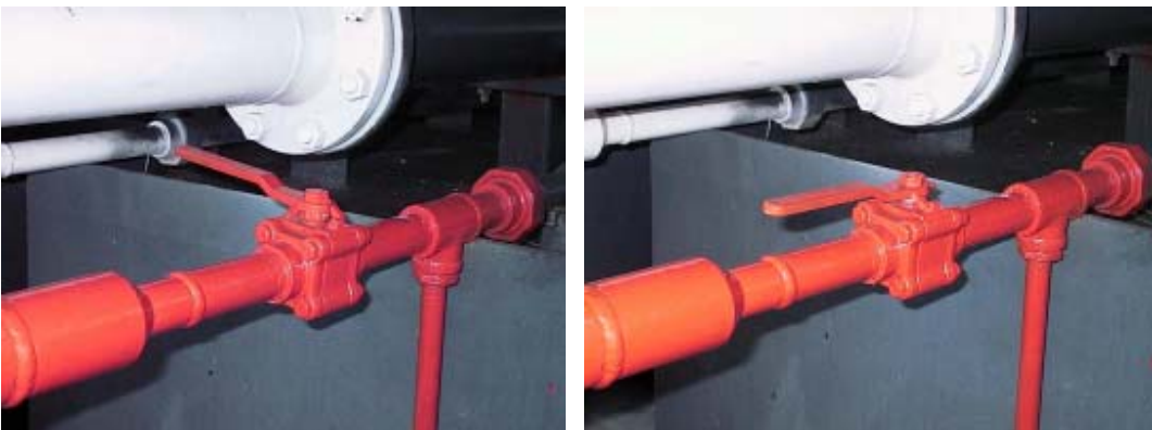
Figura 32. Se abre Válvula de aire al motor
