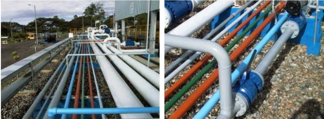
Figura 84. Identificación de colores de tuberías
