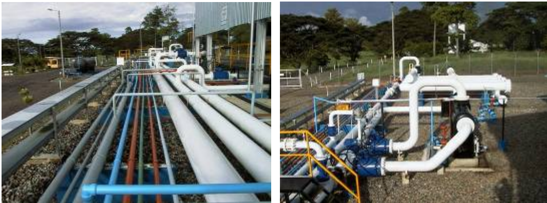
Figura 62. Sistema de tuberías de la estación compresora
