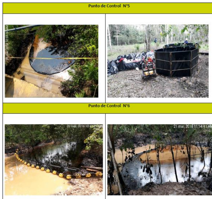
Imagen 2. Barreras instaladas en los puntos de control.
