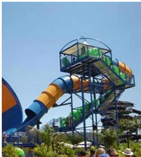
Figura 12. Torre de acceso a tobogán.
