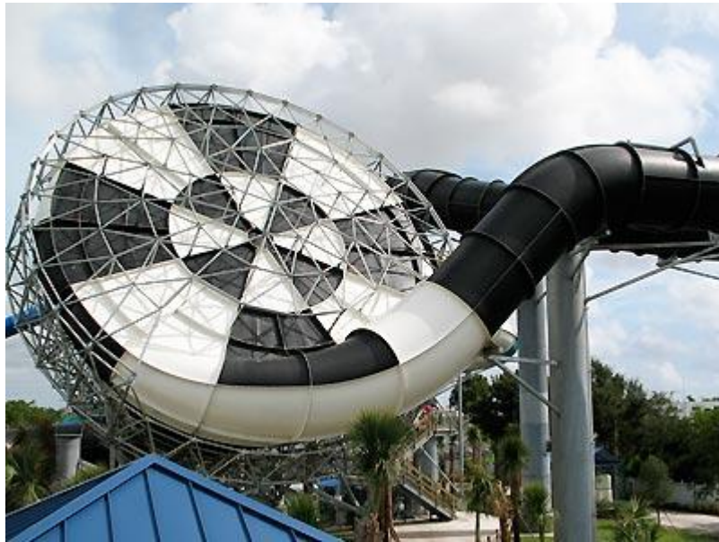
Figura 9. Geometría especial para tobogán multiusuario.
