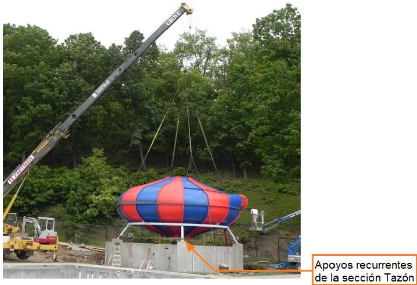
Figura 72. Apoyos de la sección tazón
