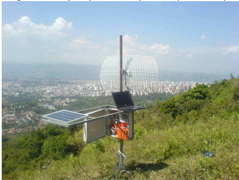
Figura 3. 4. Montaje completo del Prototipo 1 en una prueba de campo
