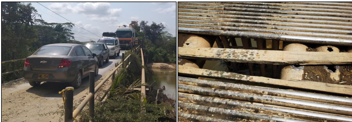
Rampas de Acceso a estructura central
