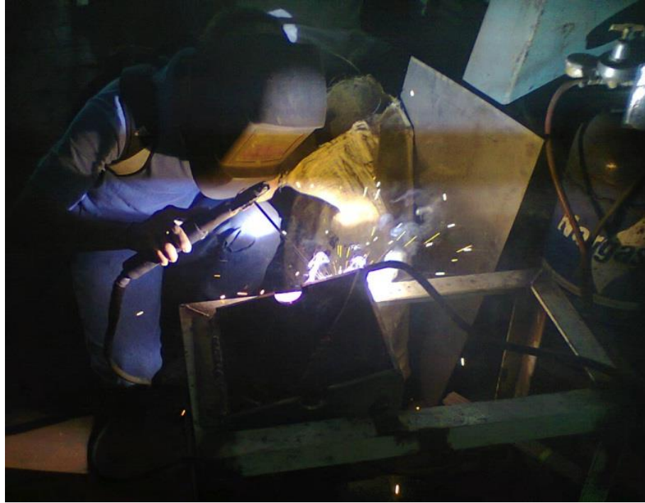
Figura 81. Fijación de los soportes de la criba.
