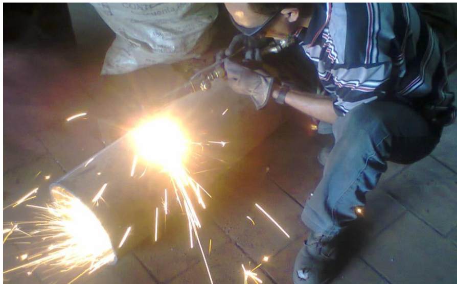
Figura 78. Corte del tubo para la criba.
