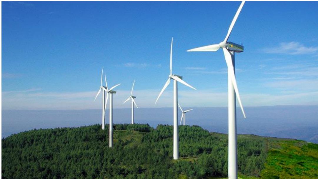
Figura 15. Aerogeneradores de eje horizontal.
