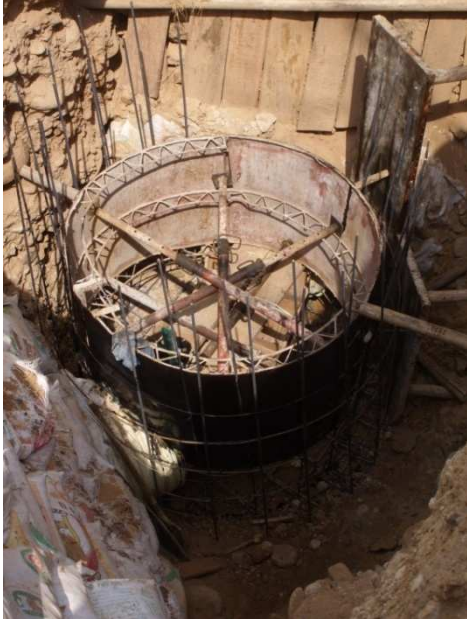
Formaleta y acero de refuerzo
