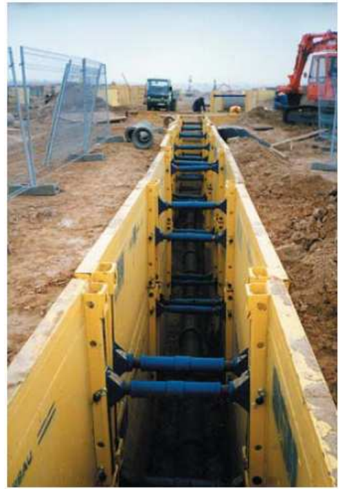
Entibación con cajones de Blindaje
