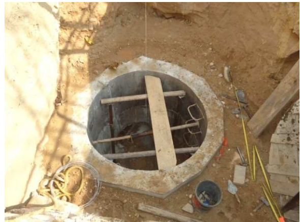
Concreto para pozo terminado
