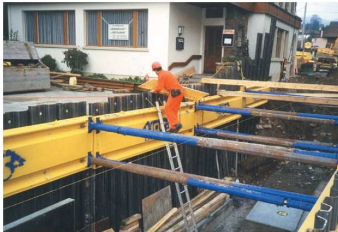
Cámaras y Tablestacas
