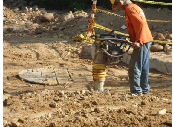
Relleno y Compactación
