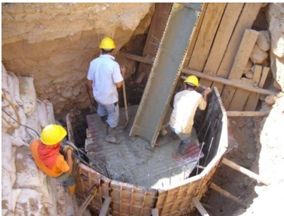
Fundida de concreto
