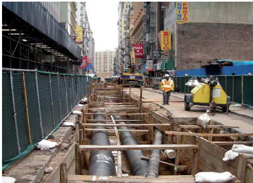
Entibado convencional en Madera
