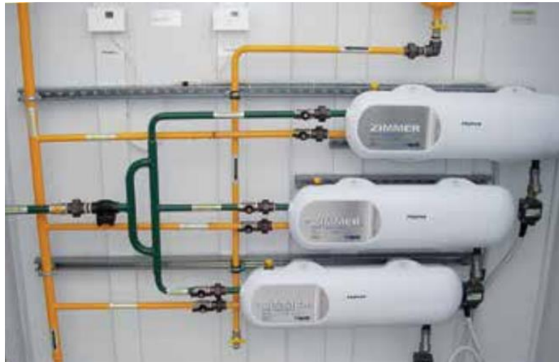
Figura 43. Instalación en paralelo de 3 vaporizadores de baño seco Zimmer
