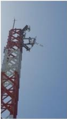
Figura 3. Fotos de la instalación de los radios y antenas del enlace TVWS Dibulla.
