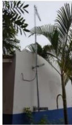
Figura 3. Fotos de la instalación de los radios y antenas del enlace TVWS Dibulla.
