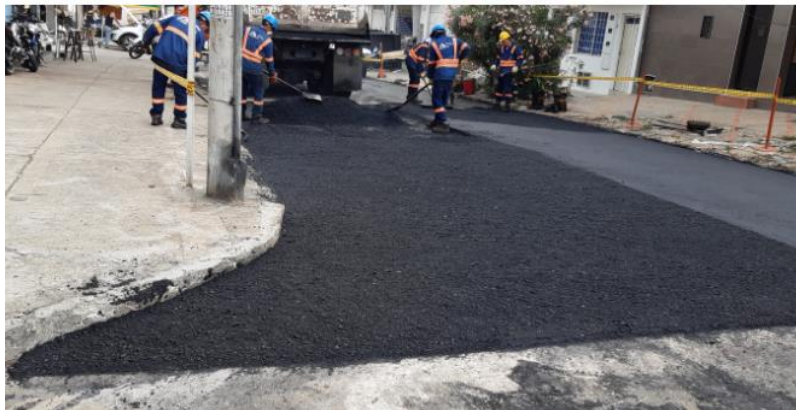
Figura 5. Aplicación de mezcla asfáltica MDC-19 realizada por el contratista Asfaltart S.A.S.
