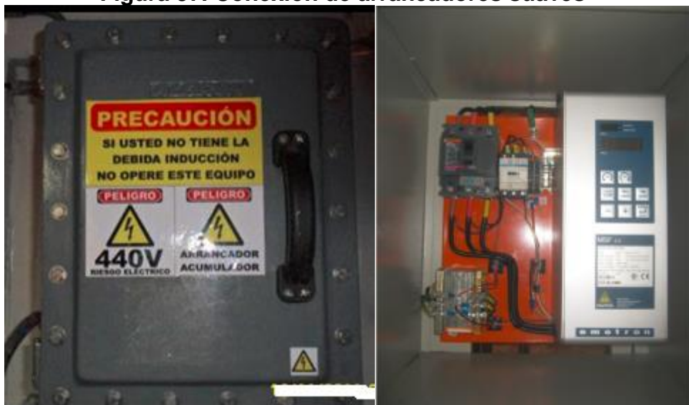
Figura 37. Conexión de arrancadores suaves
