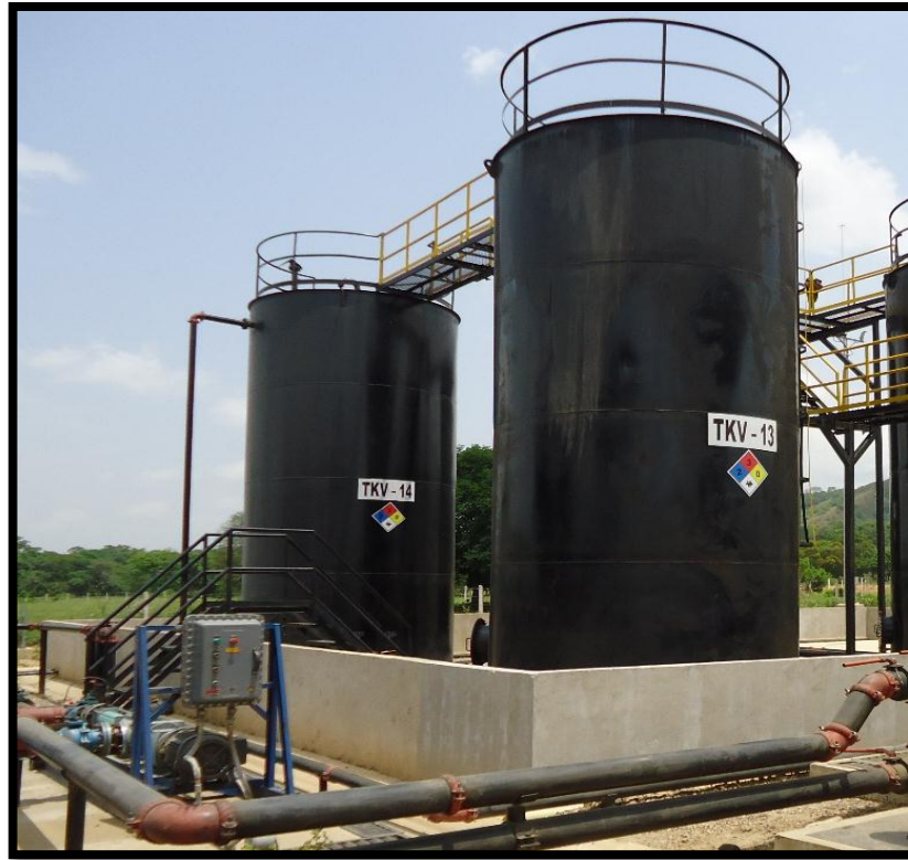
Figura 4. Diques de concreto de los módulos
