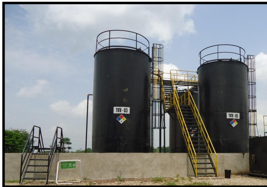
Figura 5. Vista frontal de los diques de concreto.
