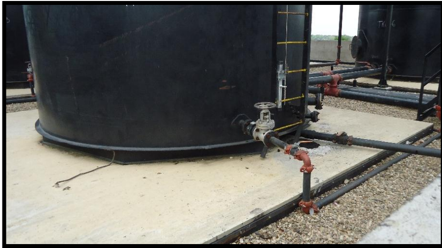
Figura 6. Placa de concreto de los tanques de almacenamiento y mezcla.
