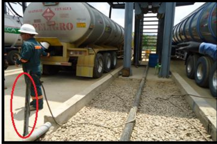
Imagen 16. Polo a tierra conectado a los carrotanques.
