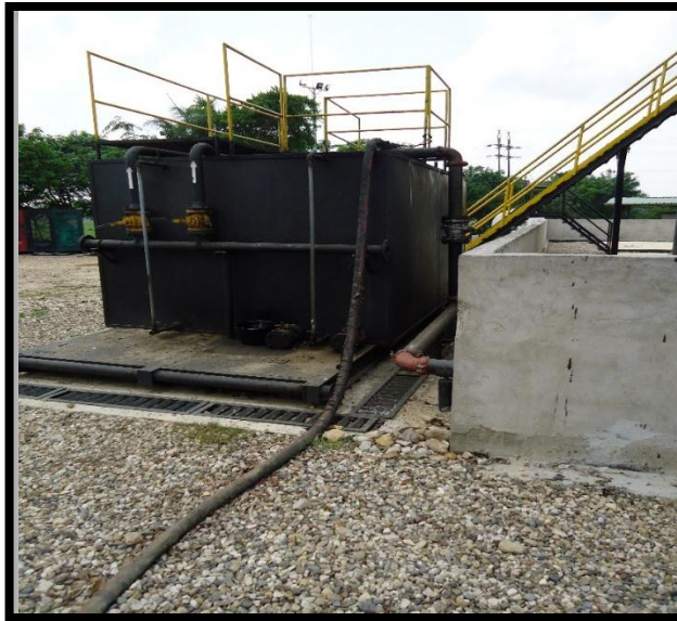
Figura 11. Catch tank de la planta Río Chiquito.
