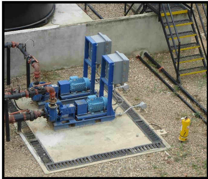
Figura 8. Placa para bomba centrífuga.
