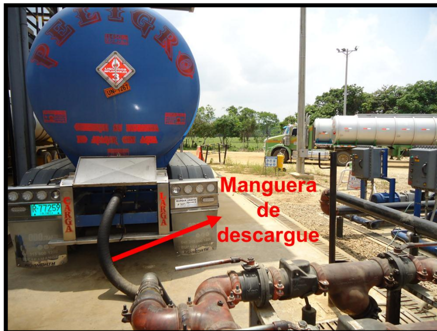
Imagen 1. Estación del vehículo en la zona de descarga
