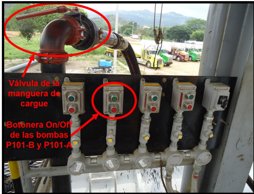
Imagen 21. Válvula de la manguera de carga
