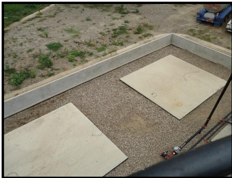
Figura 7. Placas extra para futuros tanques
