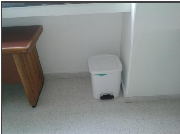
Figuras 90 y 91. Pasillos del Sexto Piso
