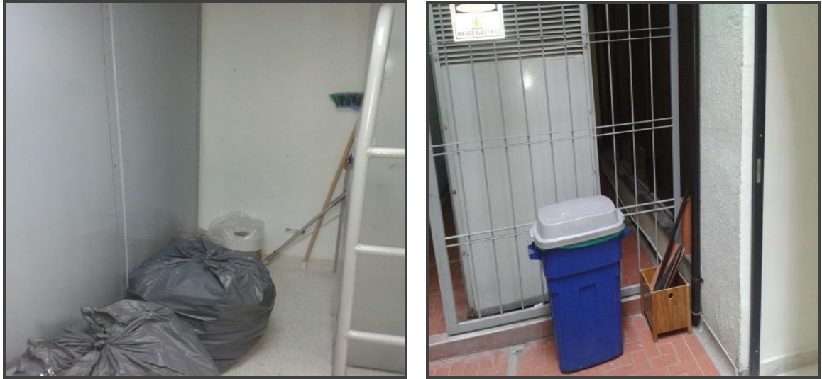
Figuras 27 y 28. Zonas aledañas al archivo central y planta eléctrica
