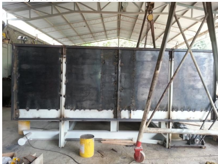
Ilustración 33. Montaje de las láminas laterales
