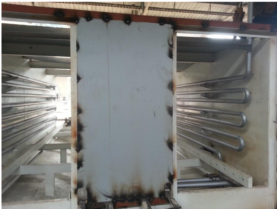
Ilustración 39. Construcción del techo
