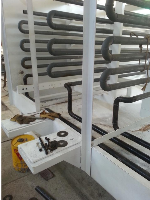
Ilustración 38. Líneas de salida de los serpentines
