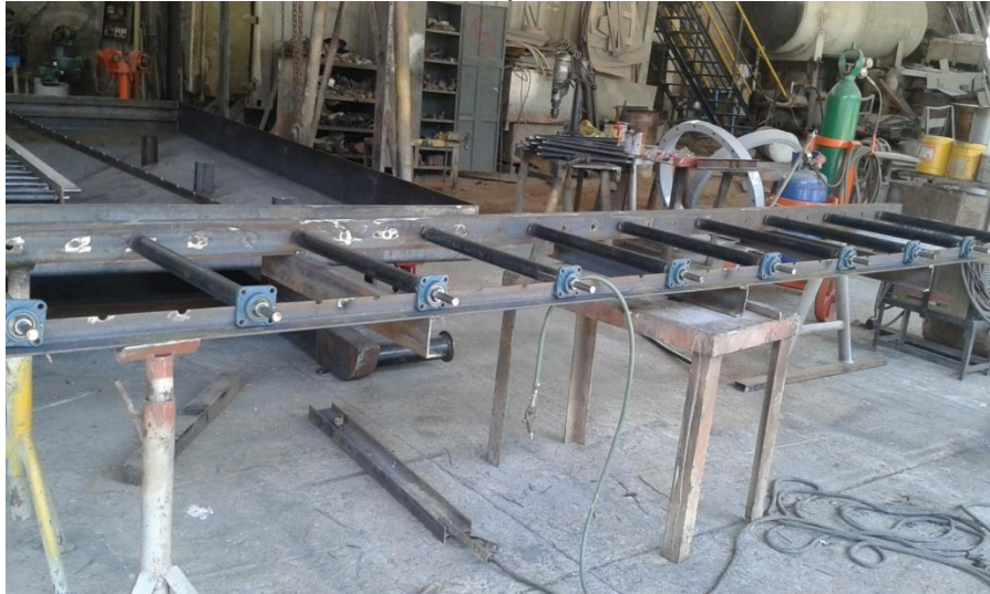
Ilustración 30. Construcción banda transportadora
