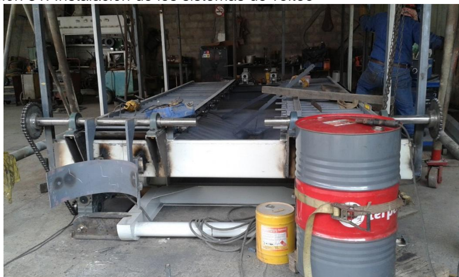
Ilustración 31. Instalación de los sistemas de volteo
