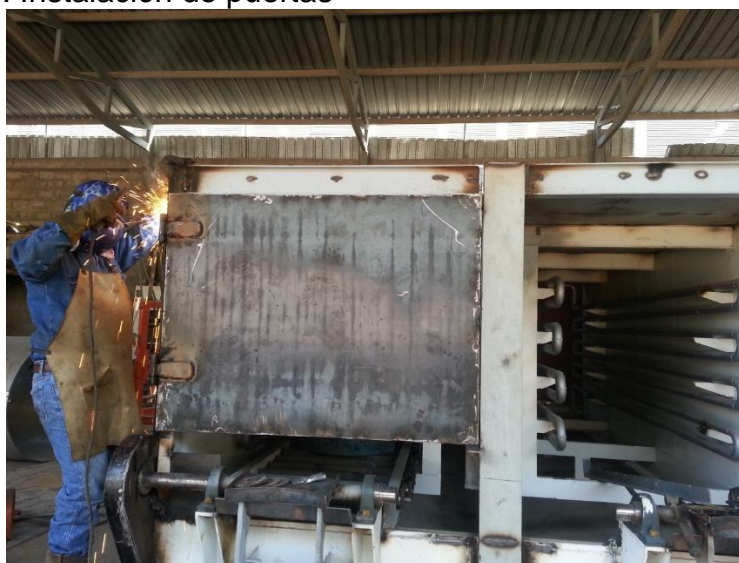
Ilustración 40. Instalación de puertas
