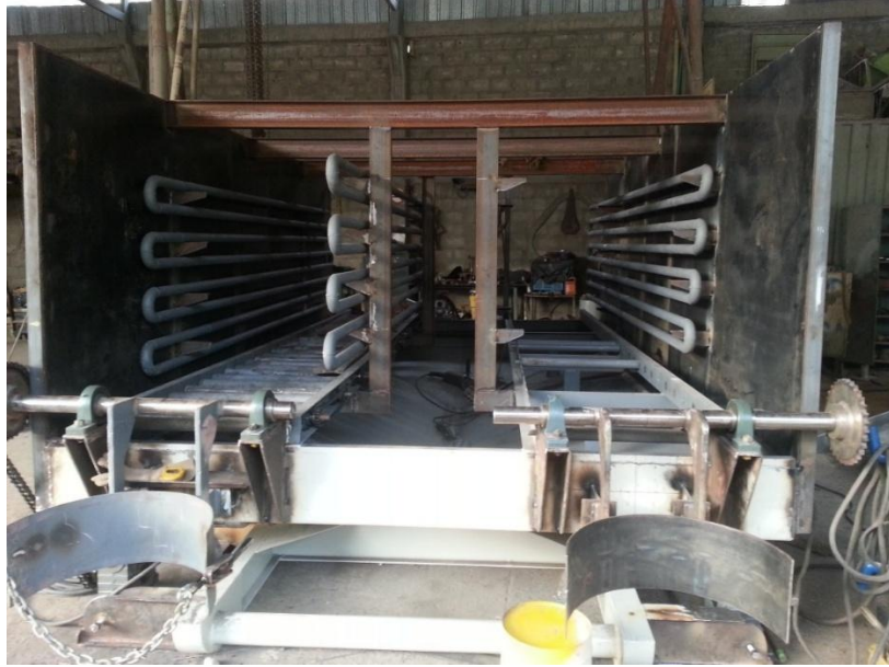
Ilustración 34. Instalación de ménsulas para serpentines
