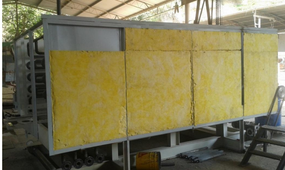
Ilustración 36. Instalación de aislante térmico
