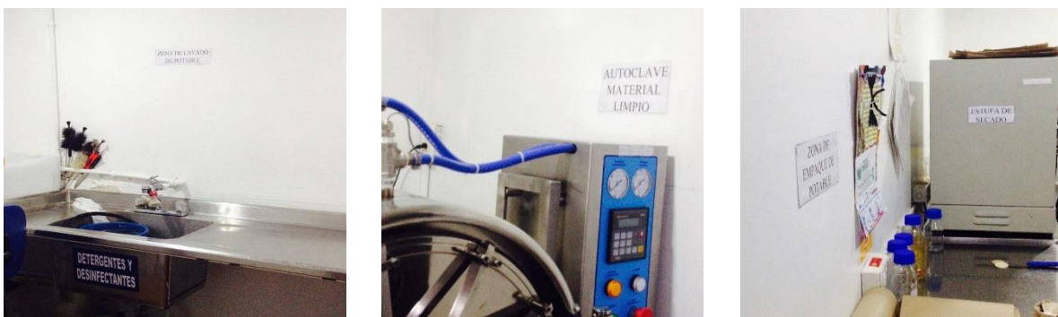
Figura 42: Señalización de los equipos y zonas de microbiología. Tomado de: Información suministrada por Acuazul Ltda
