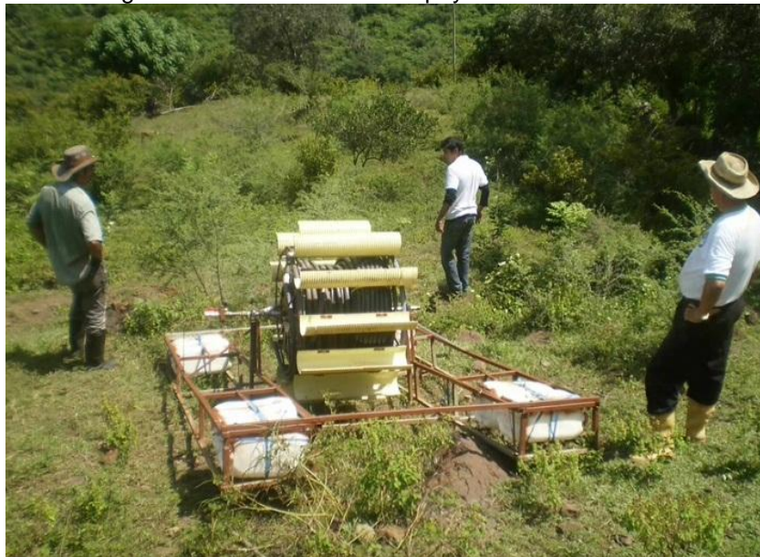
Figura 59. Instalación con el apoyo de la comunidad.
