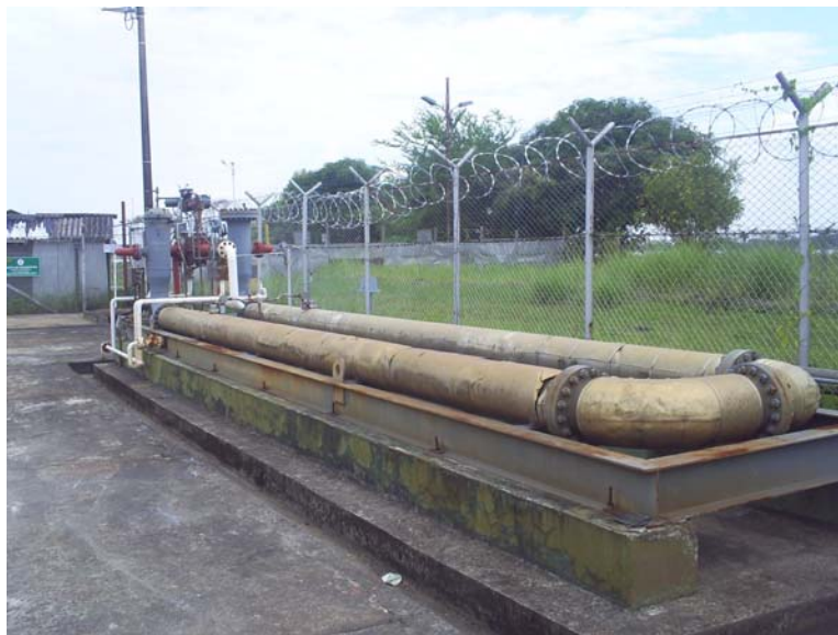
Figura 24. Probador bidireccional para GLP estación galán
