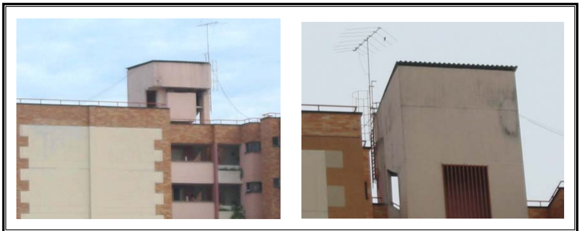
Figura 10. Tanque elevado sobre sistema combinado en la ciudad de Bucaramanga
