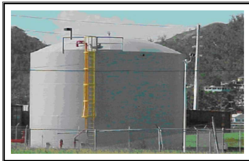
Figura 5. Tanque de acero utilizado para almacenar combustibles
