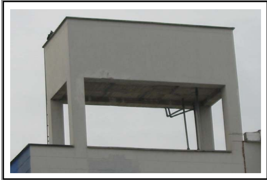
Figura 7. Tanque elevado sobre 4 columnas en la ciudad de Bucaramanga
