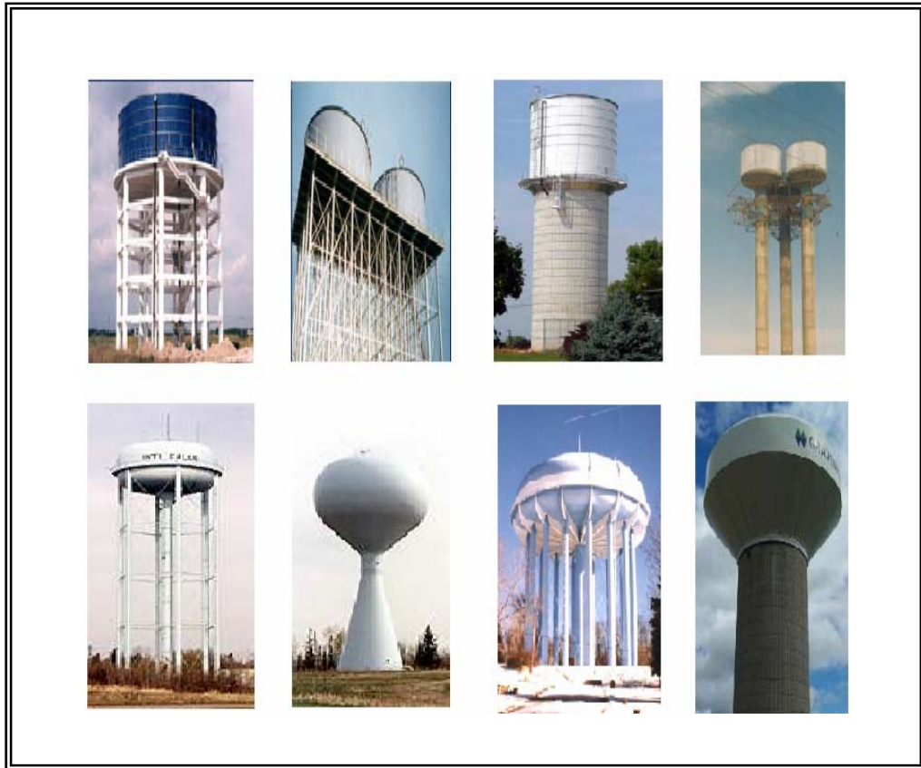
Figura 6. Diferentes formas de tanques elevados para suministro a poblaciones
