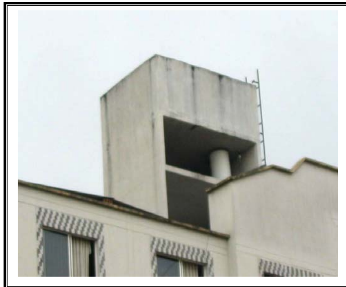
Figura 8. Tanque elevado sobre muros de carga en la ciudad de Bucaramanga
