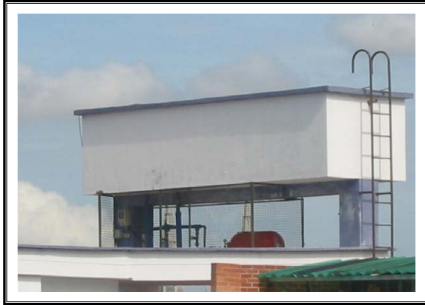
Figura 9. Tanque elevado sobre dos columnas en la ciudad de Bucaramanga
