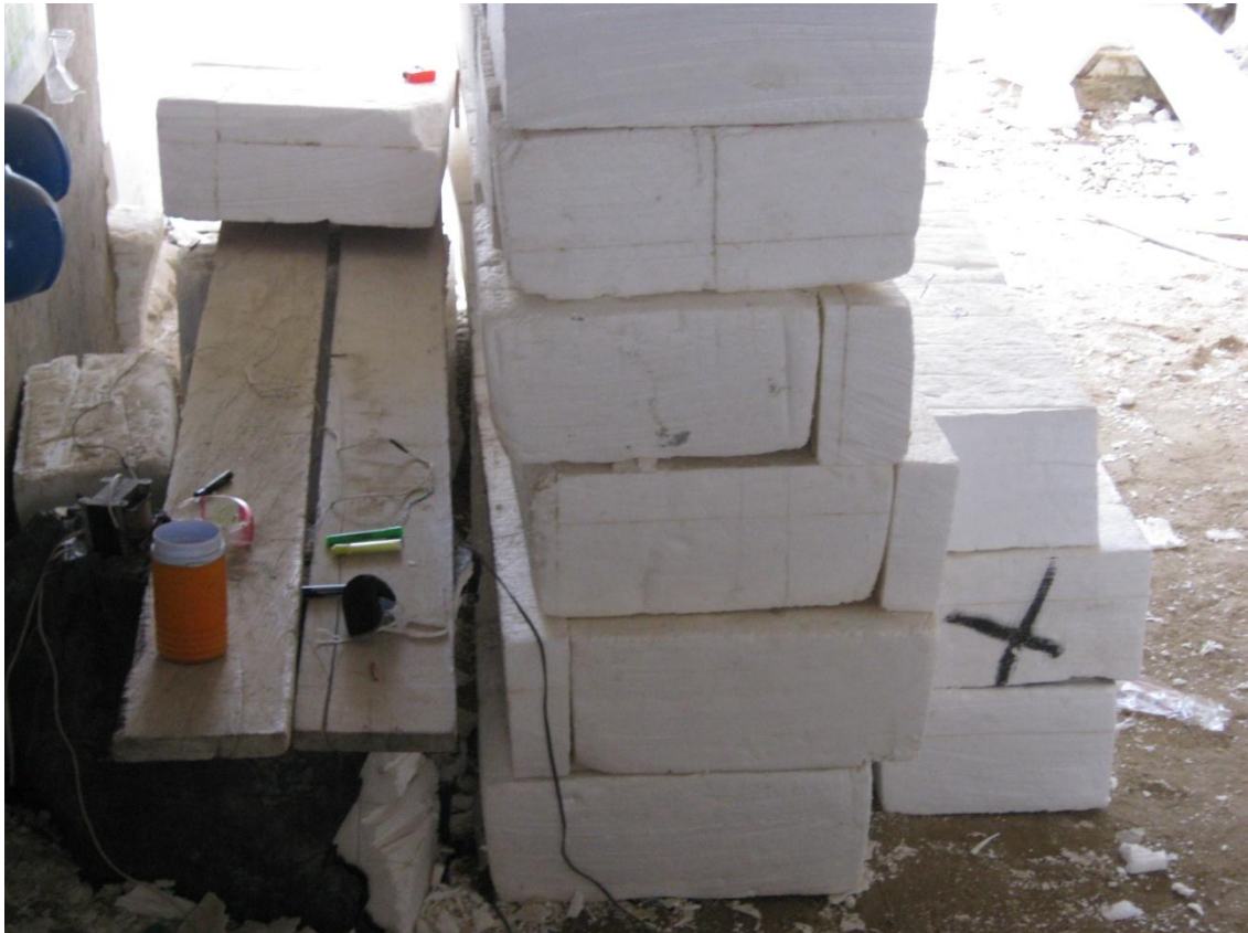
Figura 56. Corte y arreglo de casetón según medidas de la placa
