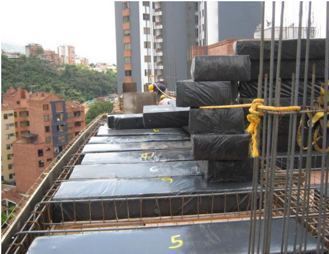
Figura 58. Limpieza en el área de trabajo con casetón de poliestireno
