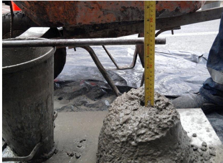
Figura 20. Medición del asentamiento
