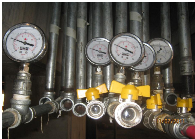
Figura 48. Verificación de la presión en los manómetros
