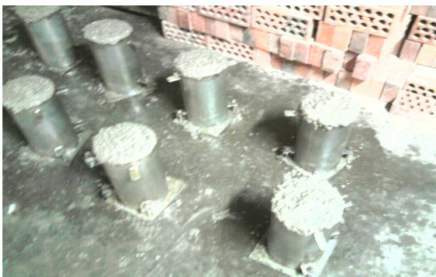
Figura 28. Cilindros antes del acabado final
