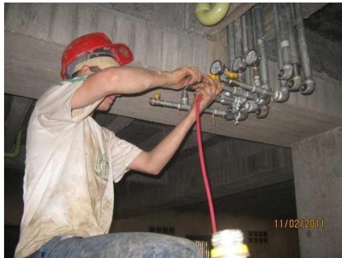
Figura 47. Llenado de las tuberías con aire
