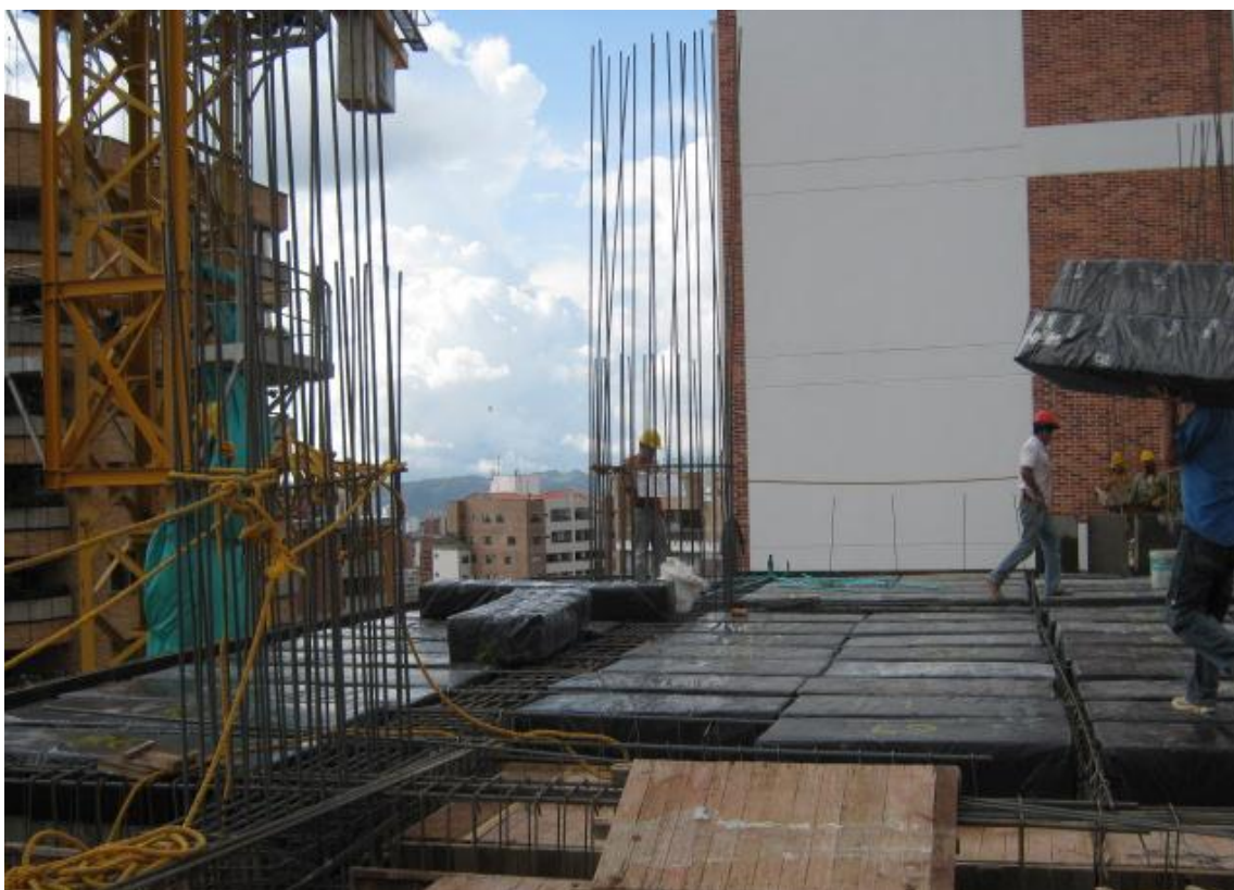
Figura 59. Colocación de casetón de poliestireno expandido
