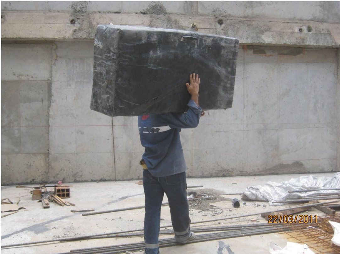
Figura 60. Transporte de casetón de poliestireno
