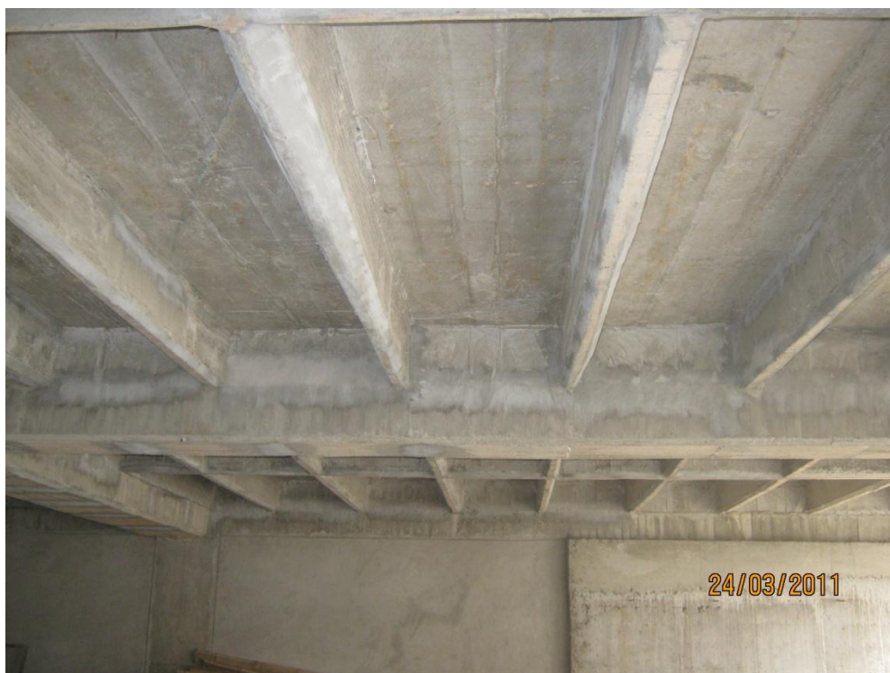
Figura 62. Acabado de placa con casetón de poliestireno
