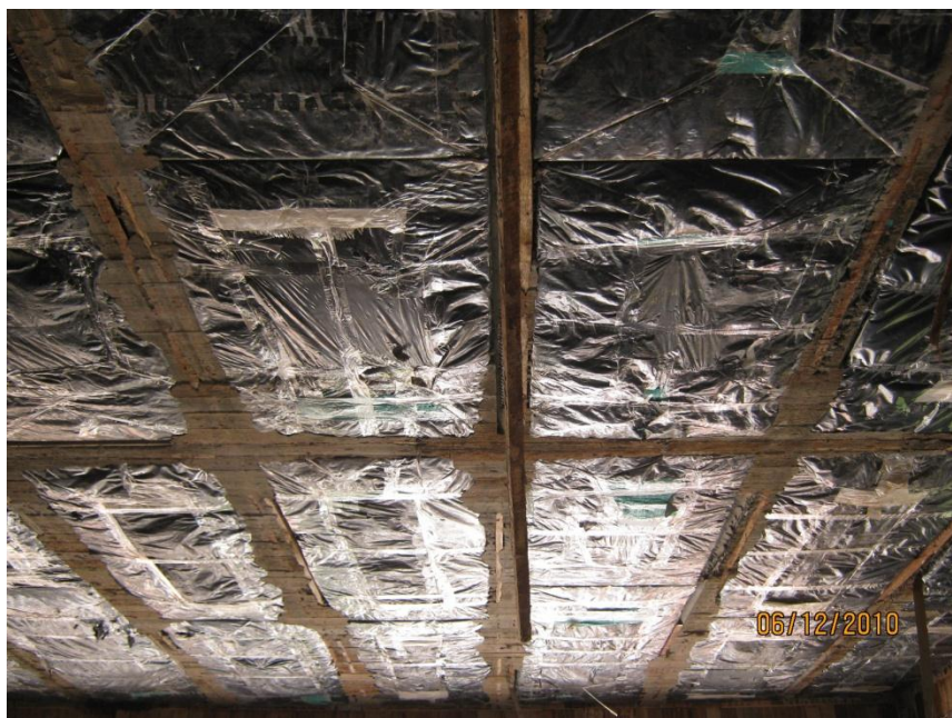
Figura 61. Vista de casetón instalado bajo placa
