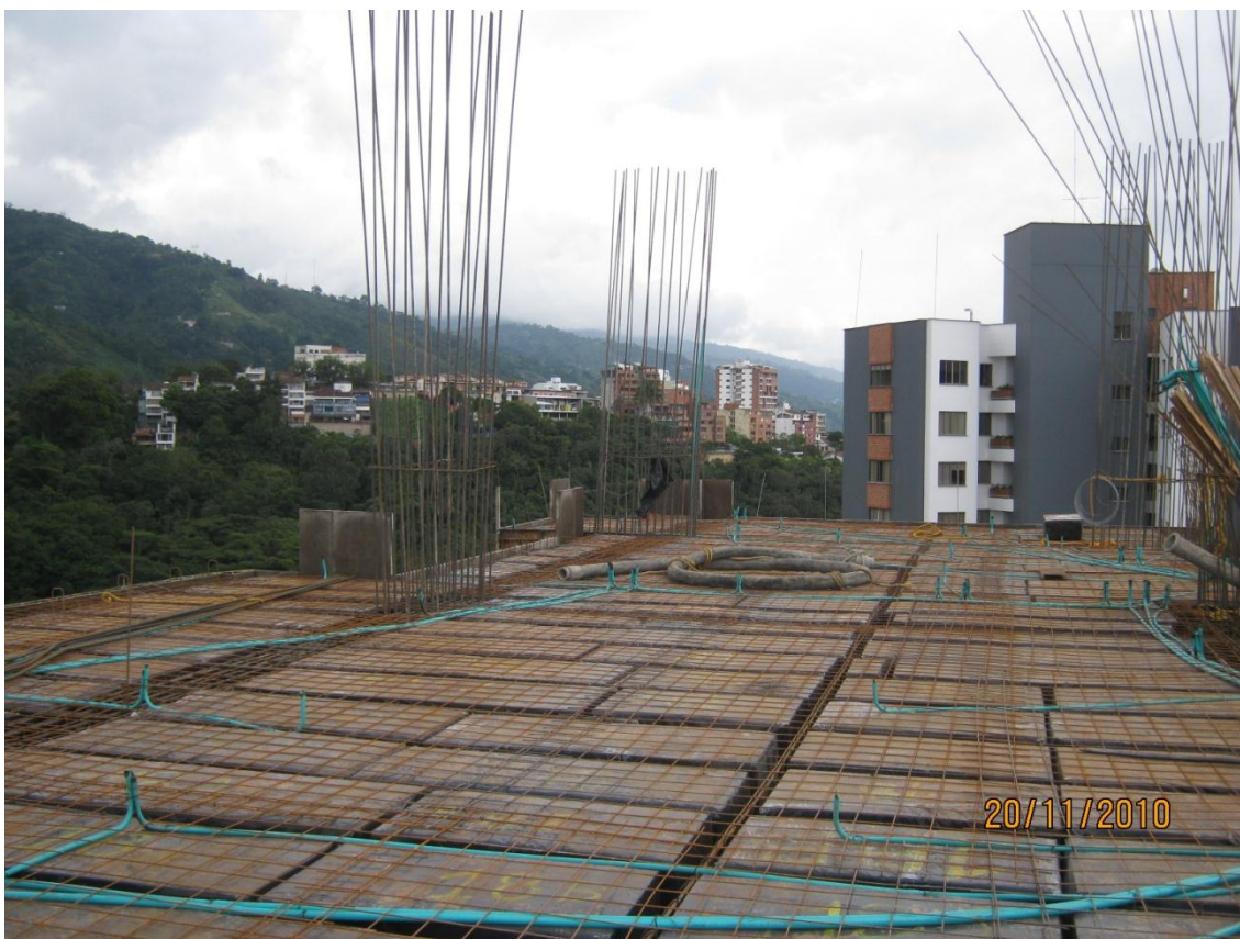
Figura 57. Placa lista con Casetón de poliestireno
