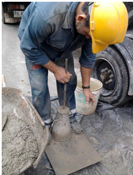
Figura 18. Compactación última capa
