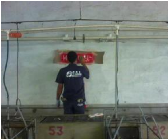
Foto 1. Proceso demarcación áreas
