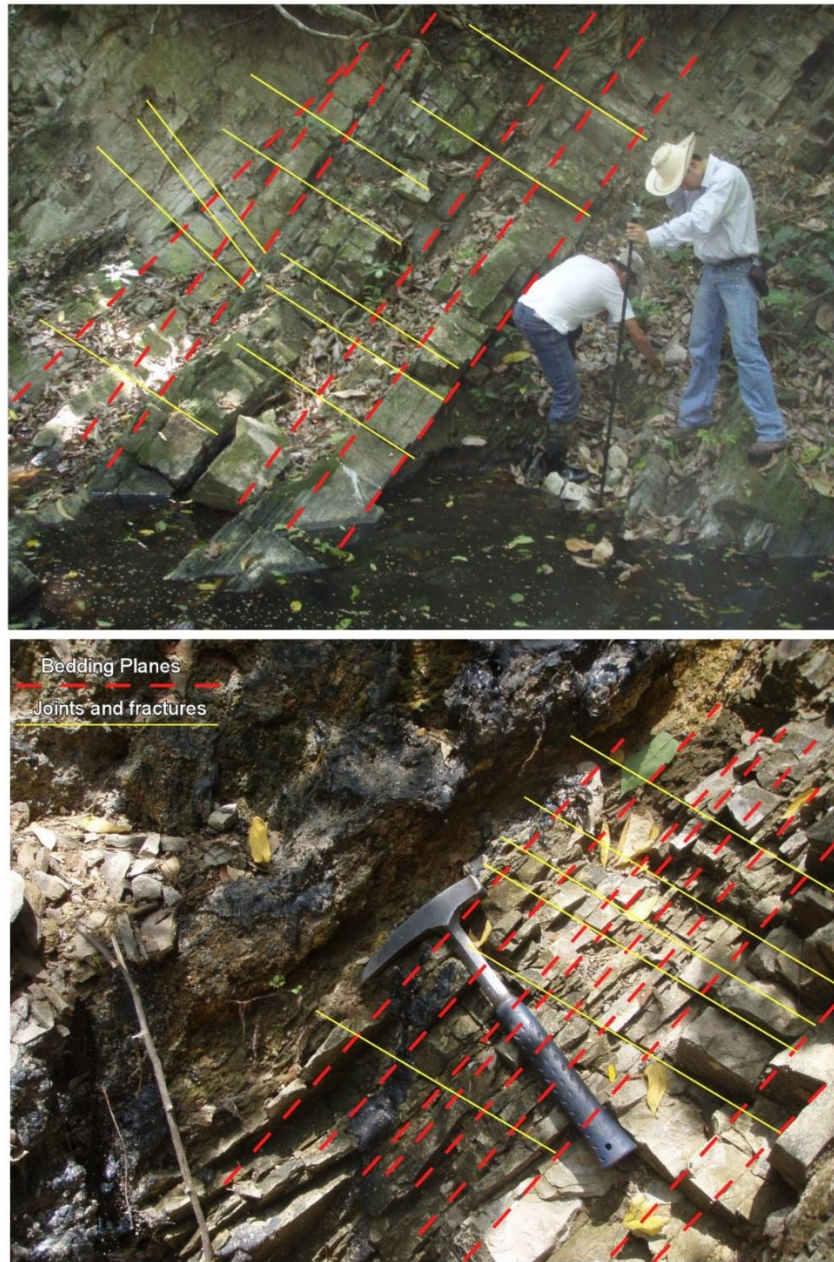
Figura 10. Imágenes de afloramiento del miembro galembo en la quebrada el Salto, Detalle de los planos de estratificación y de las diaclasas. LA longitud del fracturamiento varia de centímetros a metros.
