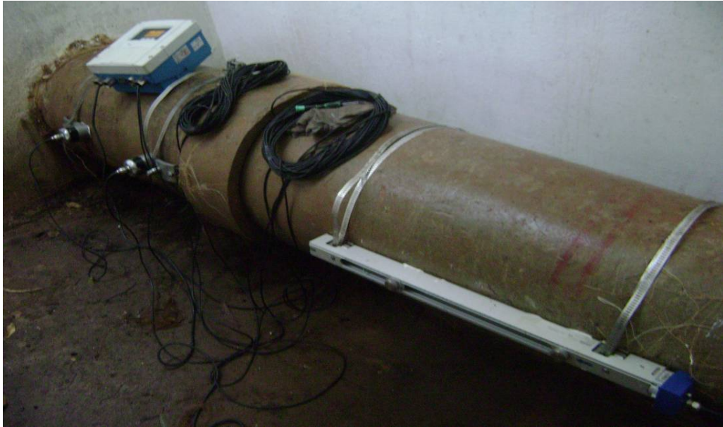
Figura 37. Montaje verificación de caudal en Mutis.
