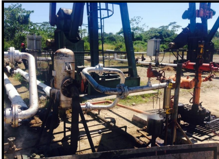
Figura 29. Instalación separador de condensado en cabeza de pozo
