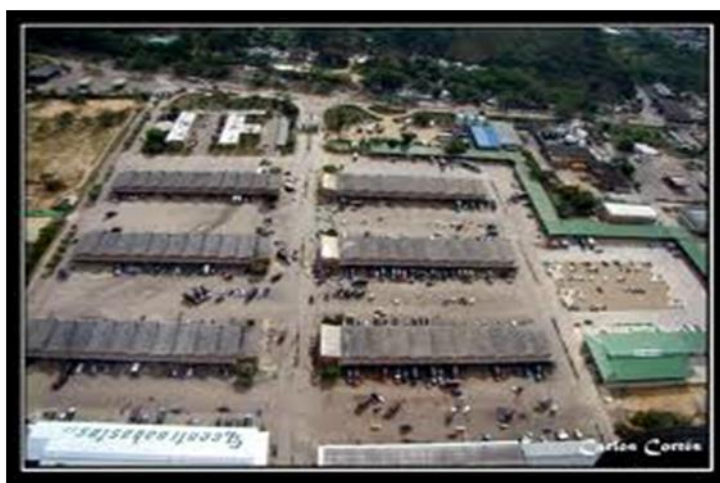
Ilustración 1. Central de Abastos de Bucaramanga S.A.
