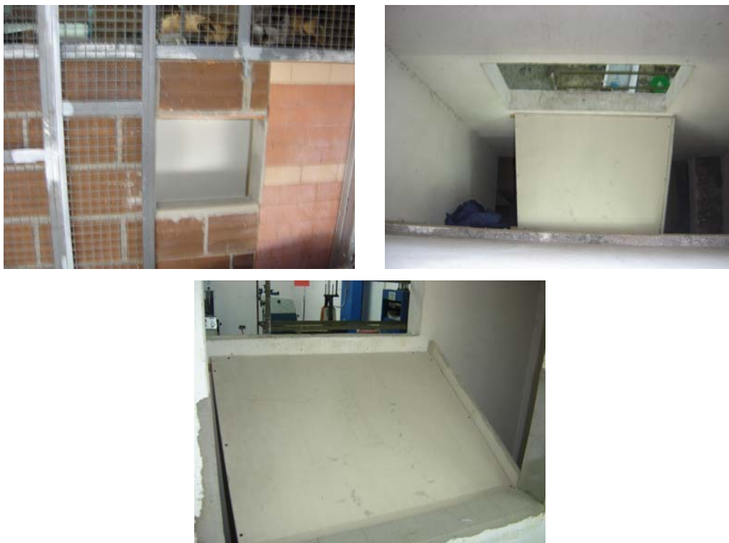
Figura 12. Túnel para tareas entre el 4° y 3° piso
