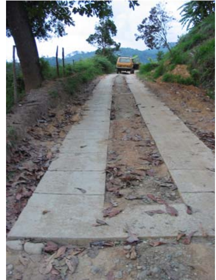
Figura 19 - Placas huellas en concreto - vía mensulí chiquito – Piedecuesta
