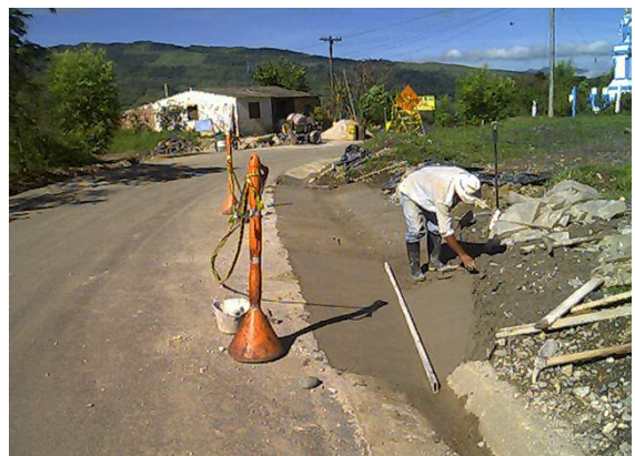
Figura 6 - Construcción de cunetas , vía Oiba- Guadalupe
