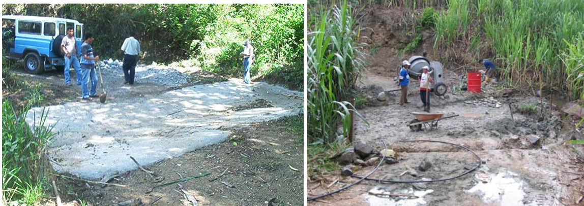
Figura 20 - Construcción de bateas - vía a la vereda el Bore – Piedecuesta
