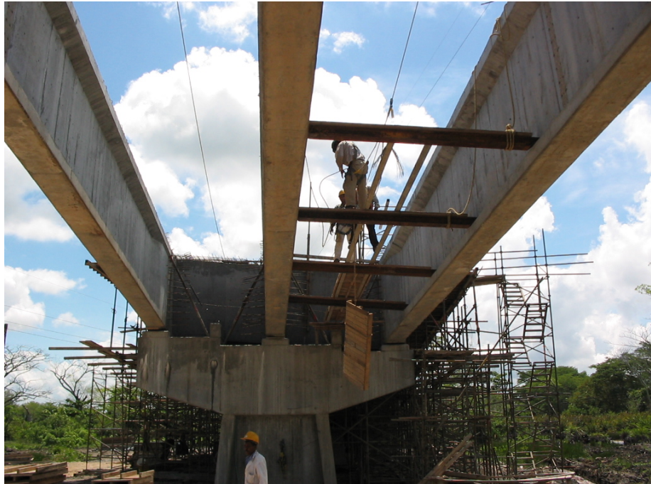
Figura 11 -Montaje de las vigas en los accesos del sector Barrancabermeja - Puente Barrancabermeja - Yondó
