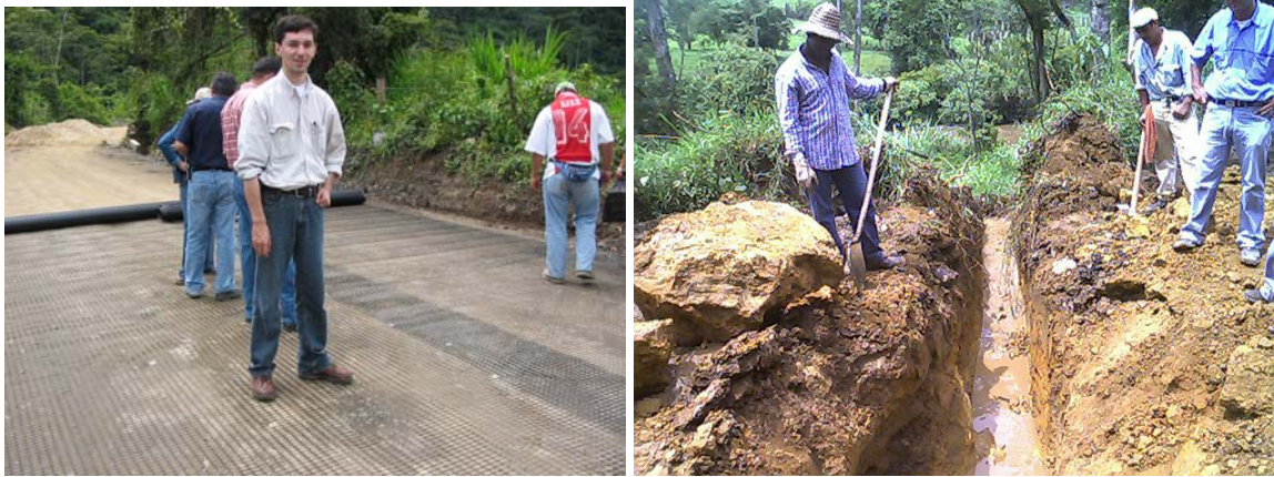
Figura 7- Extendida de geomalla y excavaciones para filtros, vía Oiba – Guadalupe
