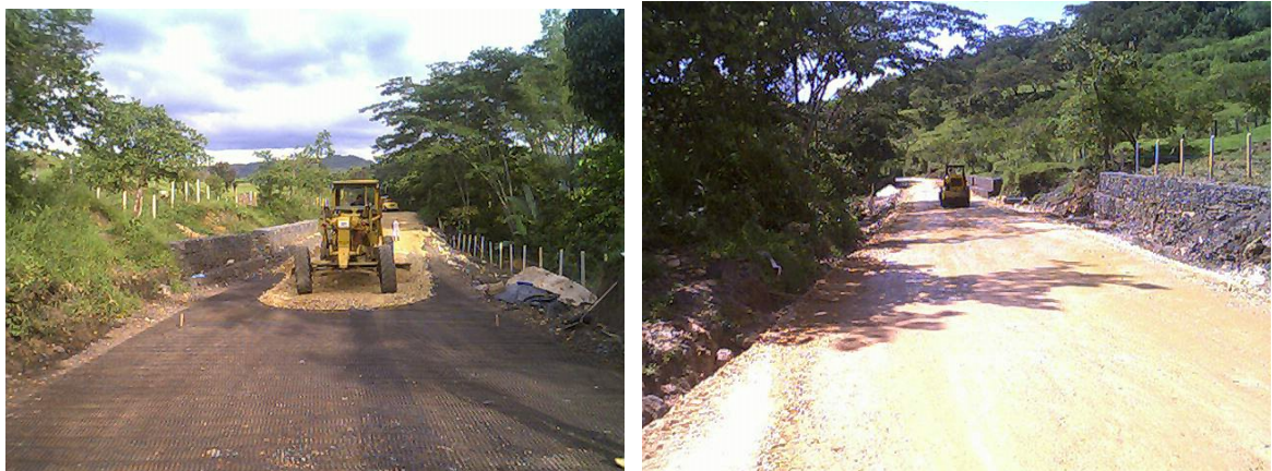
Figura 8 - Extendida y compactación del material de base, vía Oiba- Guadalupe
