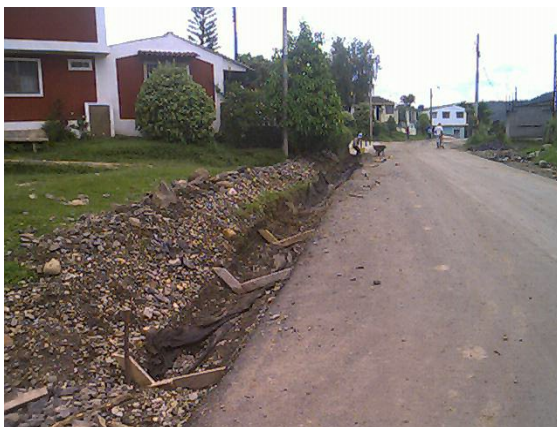
Figura 6 - Construcción de cunetas , vía Oiba- Guadalupe
