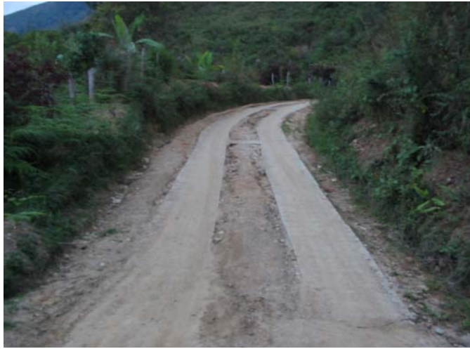
Figura 19 - Placas huellas en concreto - vía mensulí chiquito – Piedecuesta
