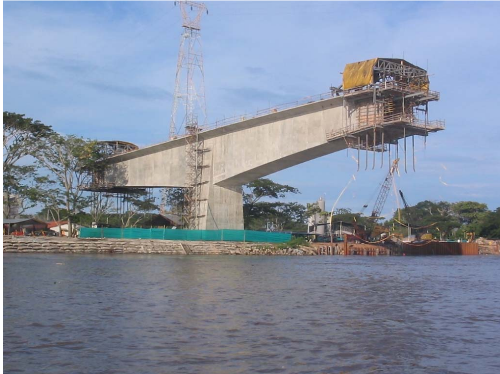
Figura 9 - Vista general del puente Barrancabermeja - Yondó
