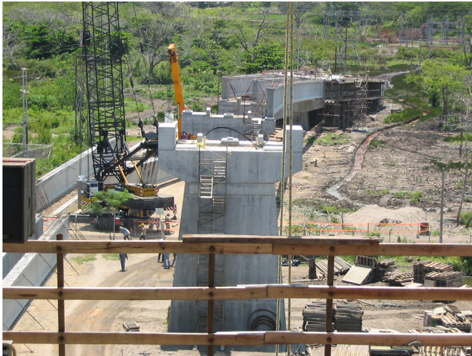
Figura 14 - Vista general del viaducto sector Barrancabermeja - Puente Barrancabermeja - Yondó
