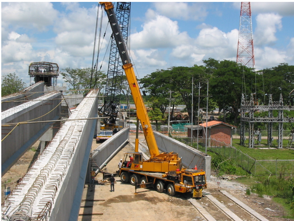
Figura 12- Proceso de izaje de las vigas en el sector Barrancabermeja - Puente Barrancabermeja - Yondó
