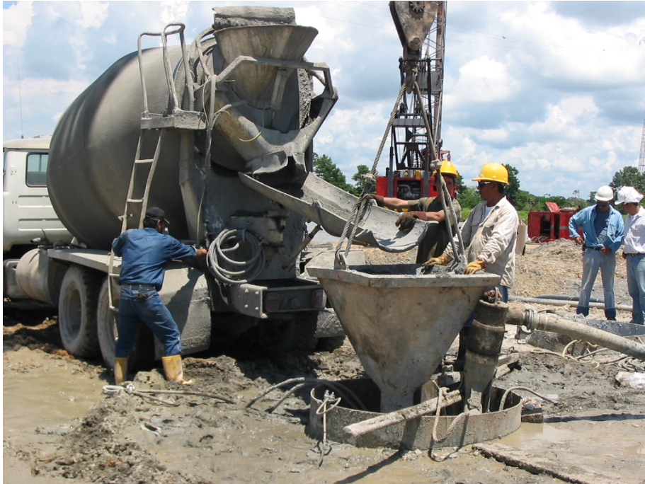
Figura 17 - Vaciado de concreto tremi para la fundición de pilotes - Puente Barrancabermeja Yondó
