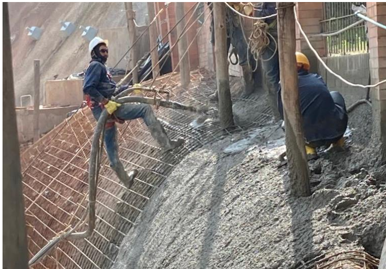
Figura 9. Lanzado de concreto en pantalla anclada Unión Temporal Erosión (Fuente propia).
