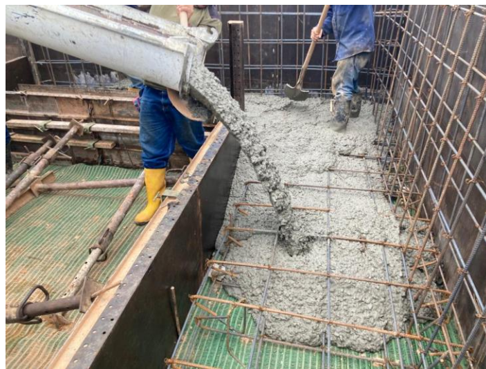
Figura 8. Fundición de muro de contención Unión Temporal Erosión (Fuente propia)
