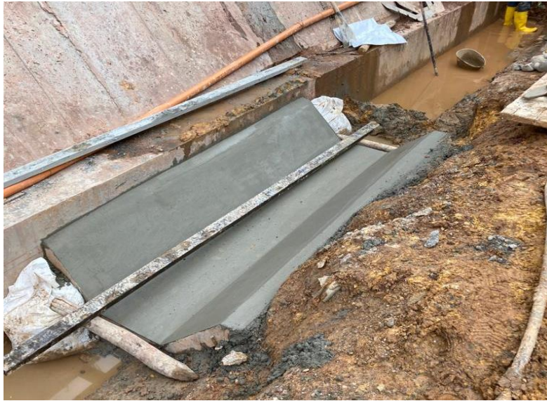
Figura 11. Fundición cuneta como elemento de tratamiento de aguas de escorrentía Unión Temporal Erosión
