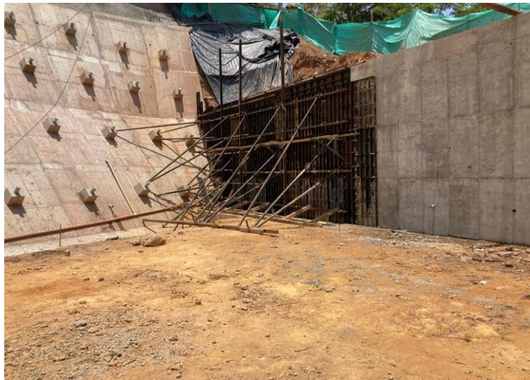
Figura 8. Instalación de formaletas para muro de contención en frente de obra por la Unión Temporal Erosión Floridablanca (Fuente propia).
