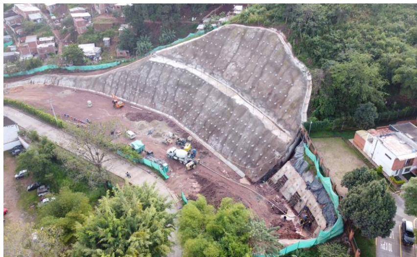
Figura 3. Obra estabilización por la Unión Temporal Erosión Floridablanca sector Talud calle 128 con transversal del oriente barrio Valverdi. (Fuente propia)
