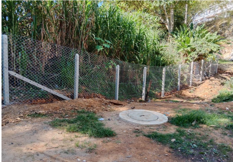
Figura 14. Instalación de malla de encerramiento como elemento de urbanismo Unión Temporal Erosión (Fuente propia).
