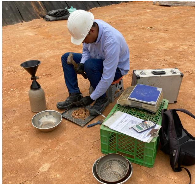
Figura 18. Supervisión de elaboración de ensayos de densidades para para construcción de muro en tierra armada (Fuente propia).
