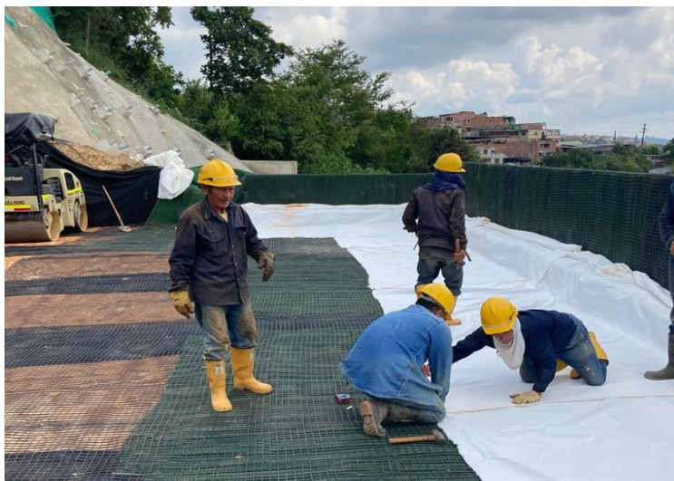
Figura 13. Instalación de elementos estructurales para construcción de muro en tierra armada Unión Temporal Erosión (Fuente propia).
