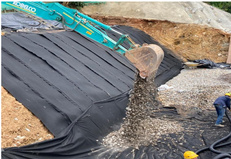
Figura 12. Construcción de lecho filtrante en elaboración de muro en tierra armada Unión Temporal Erosión (Fuente propia).
