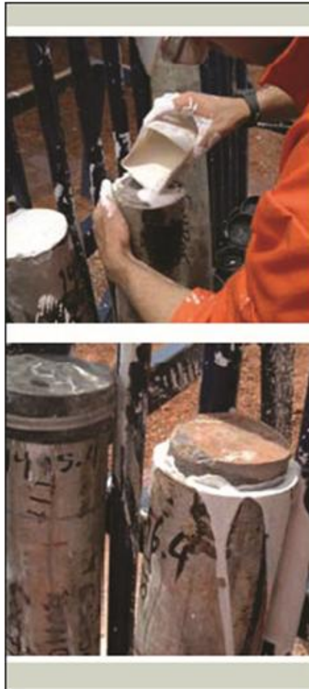
Figura 41. Estabilización mecánica con resina
