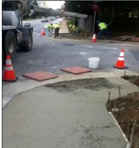
Figura 5. Construcción de Rampas peatonales.
