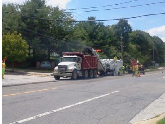
Figura 14. Daños en la capa de rodadura
