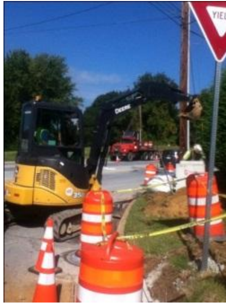
Figura 10. Instalación de Caja de Conexiones
