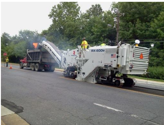
Figura 15. Operación de Fresado.
