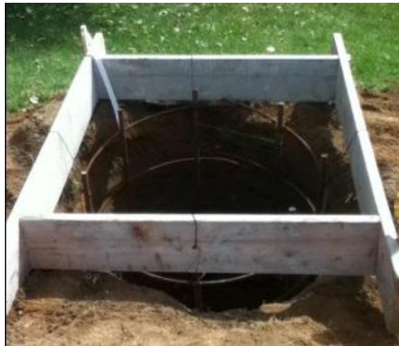
Figura 9. Base de Mástil (Fundación)
