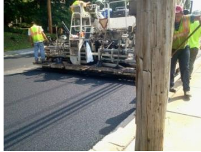
Figura 16. Operación de Pavimentación
