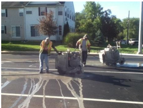
Figura 12. Instalación de Detectores de Tráfico
