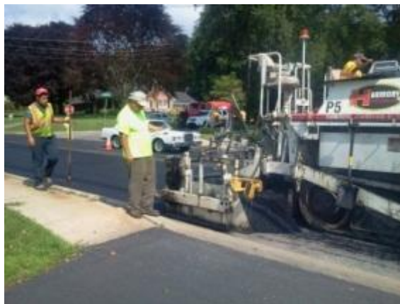
Figura18. Detalle de operaciones de Pavimentación
