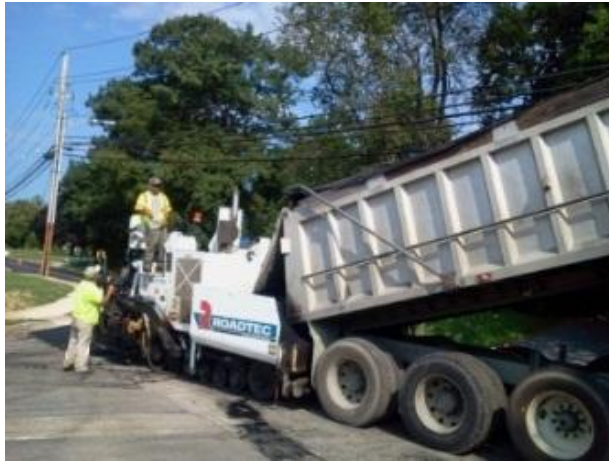
Figura 17. Camión vertiendo material en el esparcidor.
