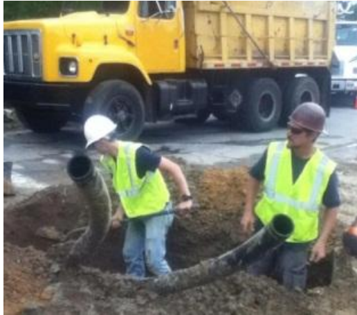
Figura 11. Instalación de Ductos para Circuito Subterráneo
