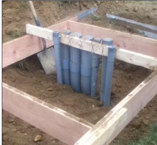
Figura 8. Preparación de la Base de Cabina de Control
