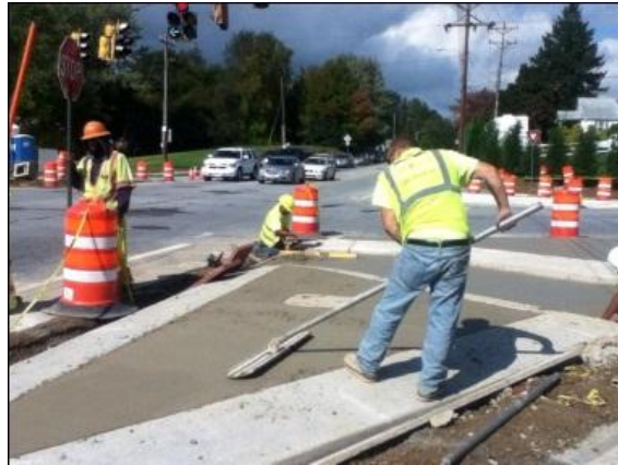
Figura 7. Construcción de Isla Canalizadora de Tráfico
