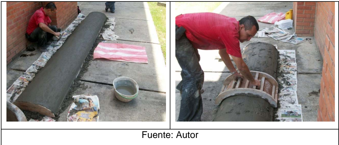
Fotografía 4.6. Acabado del elemento de aligeramiento.
