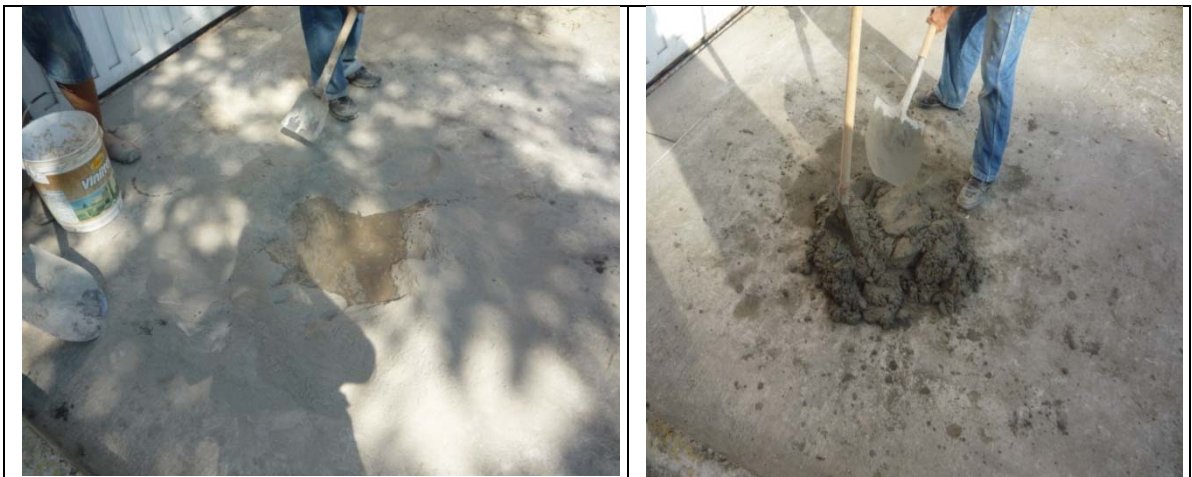
Fotografía 5.3. Preparación del mortero.
