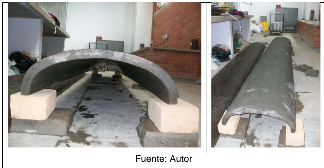
Fotografía 4.8. Desencofrado del elemento de aligeramiento.
