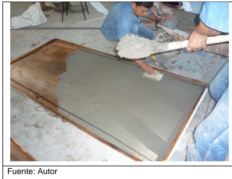
Fotografía 5.4. Aplicación del mortero.
