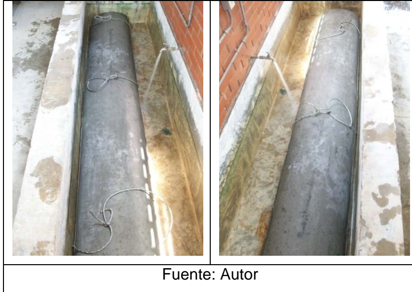
Fotografía 4.7. Curado del elemento de aligeramiento.
