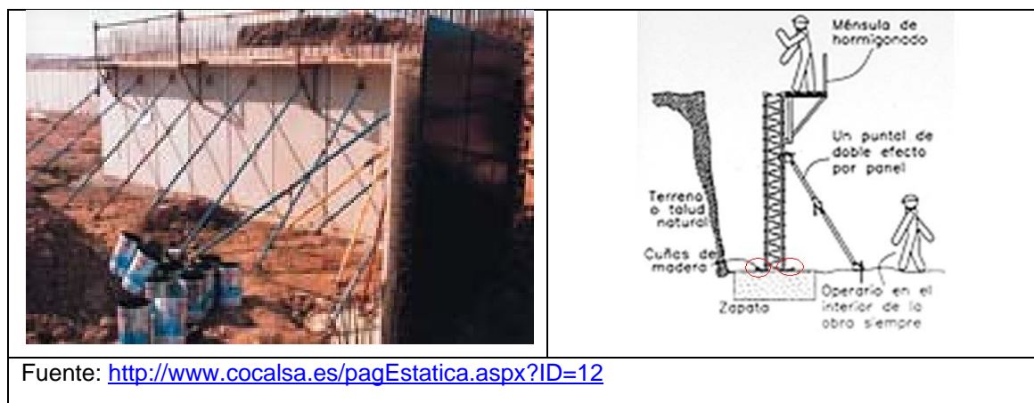
Fotografía 5.6. Restricción de paneles lateralmente.
