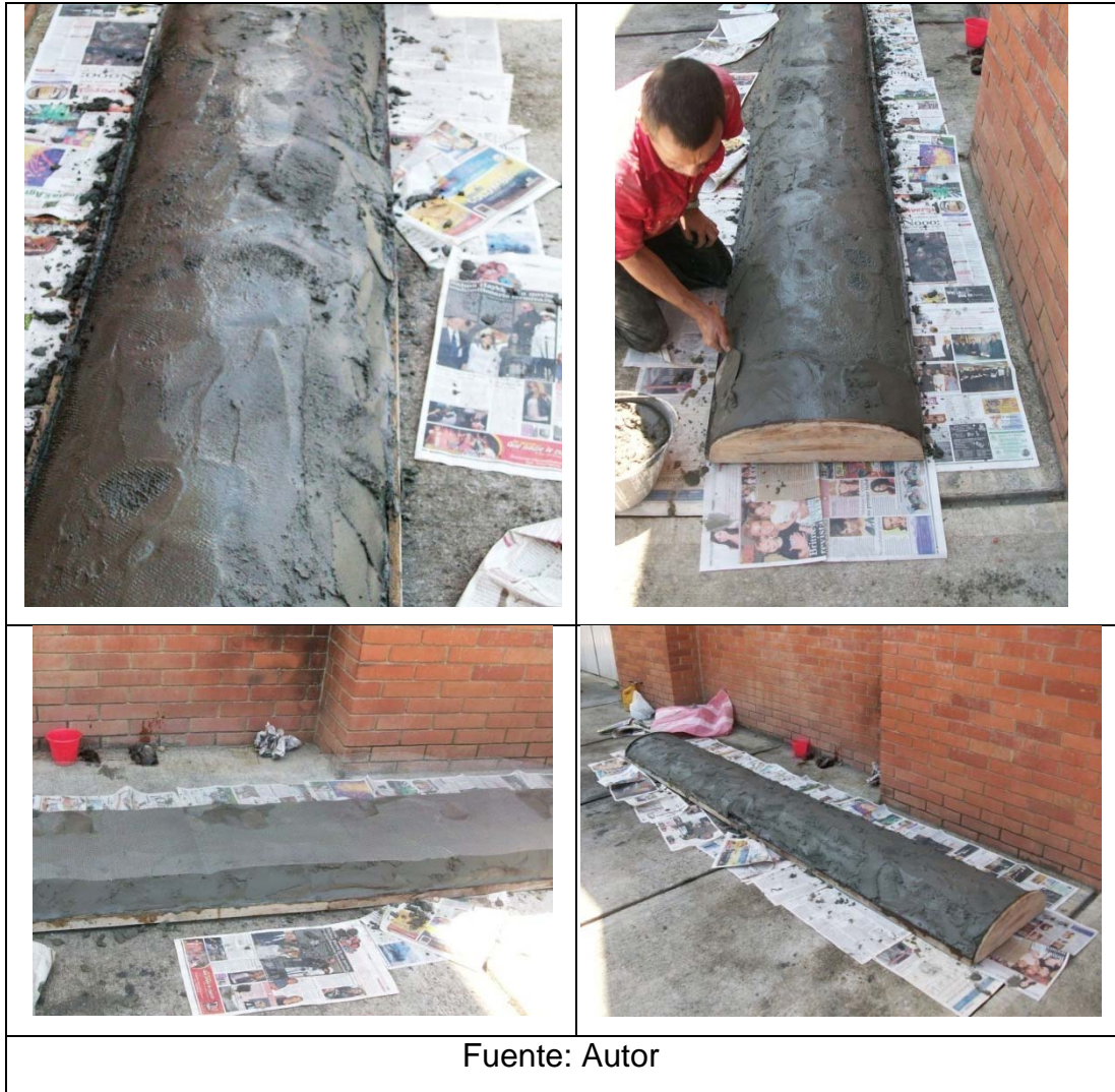
Fotografía 4.5. Aplicación del mortero
