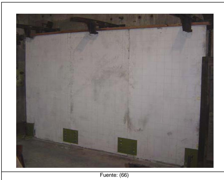
Fotografía 5.7 Conexión Paneles de Ferrocemento.
