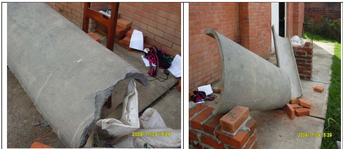
Fotografía 4.14. Colapso del elemento
