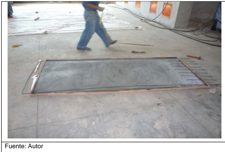
Fotografía 5.2. Refuerzo principal y pines de anclajes.
