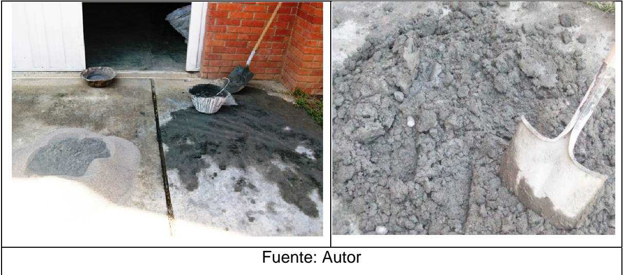
Fotografía 4.4. Preparación del mortero.
