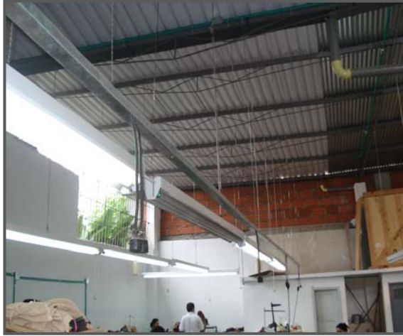
Nuevas Instalaciones eléctricas y remodelación de techo en la planta de ARISTON Sport
