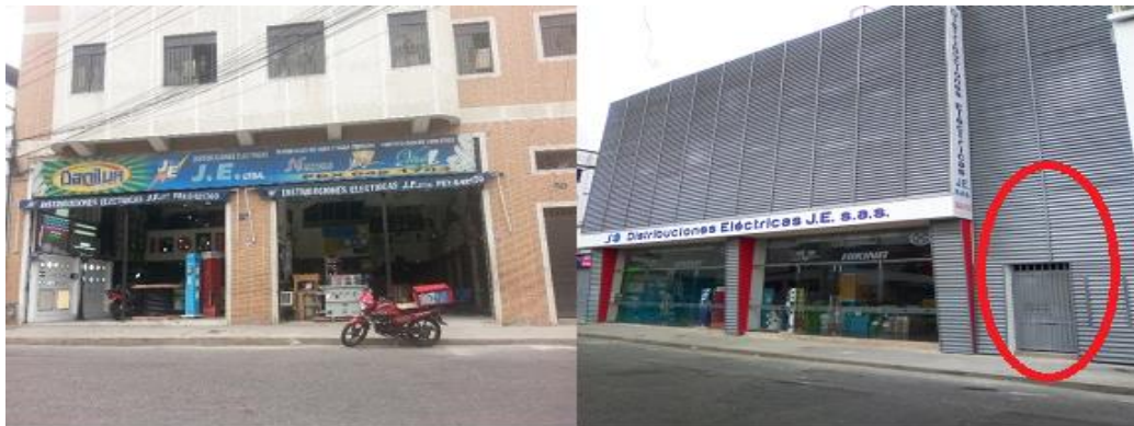
Figura 29. Remodelación y nueva entrada para la recepción de mercancía
