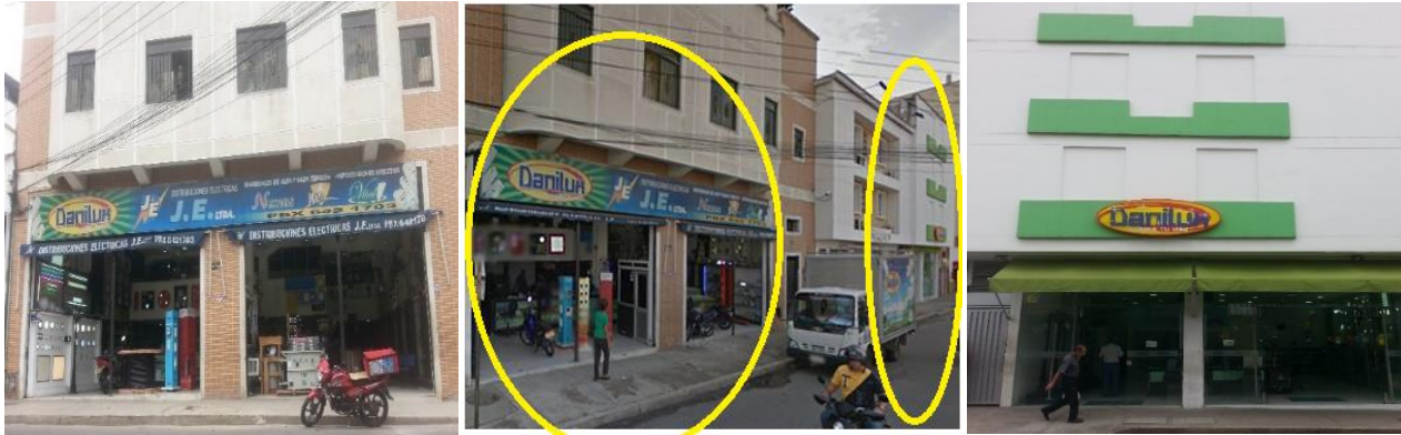
Figura 2. Fachada de Distribuciones Eléctricas JE S.A.S.
